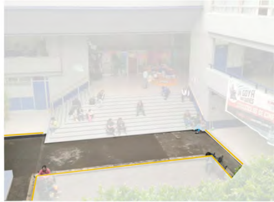
D. Diferencia de nivel y pavimentación
