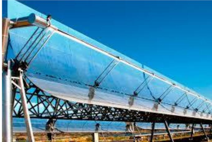
*Figura 17 Colectores solares*
