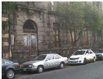
Imagen 2 Deterioro del entorno
