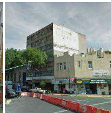
Edificio de 7 niveles Calle Lucerna Esq. Abraham González
