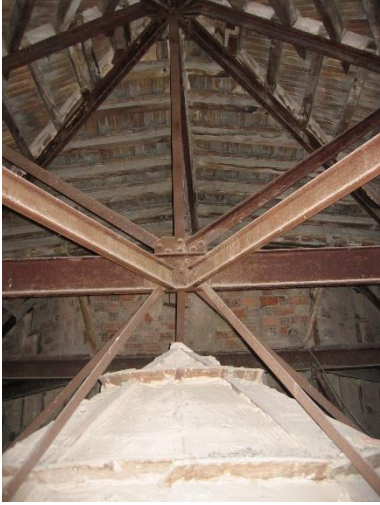
Figura 45. Estructura metálica de cubierta.
