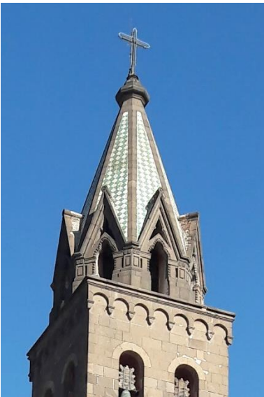
Figura 107. Chapitel de torre campanario.
