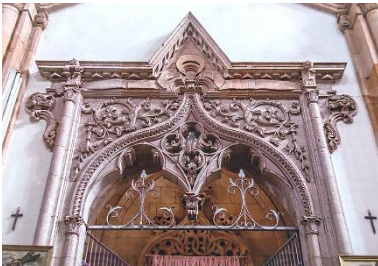
Figura 101. Detalle de tallado de cantería sobre vano de acceso.
