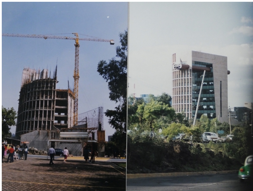
FIGURA 2.3 izquierda: edificio en construcción en la reserva territorial del Fondo de Cultura Económica en el Ajusco. Derecha: edificio de las nuevas instalaciones terminado, construidas con recursos del FCE y del Gobierno Federal a partes iguales.
