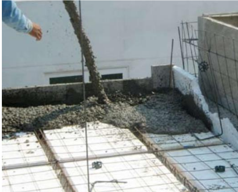
Figura 6 Acero en la azotea
