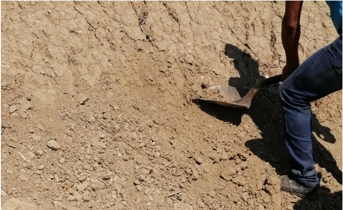
Figura14. Extracción de material arcilloso tipo lutita/color café/ uso de ella para el mejoramiento del suelo inestables con el uso de caliche mediante porcentajes de mezclas de ambas. (Tuxtla Gutiérrez Chiapas - Suchiapa 16°38'23.9" N 93°06'00.4").
