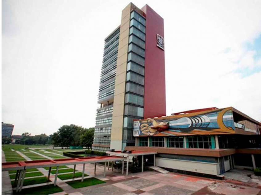
Ilustración 25 Vista del edificio de Rectoría de la UNAM junto con el mural de David Alfaro Siqueiros << Las Fechas En La Historia de México>>. Imagen recuperada de: https://www.ensenadaonline.net/2019/10/01/defienden-examen-de-ingreso-a-la-unam-candidatos-a-rectoria
