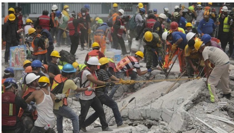
Ilustración 18 Fotografía de rescatistas durante el sismo del 19 de septiembre de 2017. Fotografía de Cultura Colectiva recuperada en https://elcentinelabcs.com/proteccion-civil-hara-un-macrosimulacro-de-sismo-este-19-de-septiembre/
