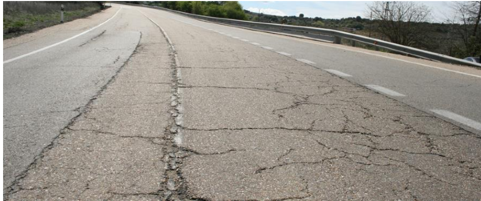
ILUSTRACIÓN 42 FATIGA DE UN PAVIMENTO; FUENTE: INTERNET
