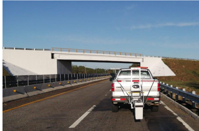
ILUSTRACIÓN 15 GPR EN FUNCIONAMIENTO; FUENTE: YUTAVE INGENIERIA SA DE CV
