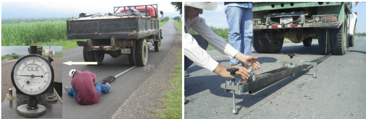
ILUSTRACIÓN 1 EQUIPO DISCONTINUO PARA LA DETERMINACIÓN DE DEFLEXIONES VIGA BENKELMAN. FUENTE: UNIVERSIDAD ANDINA DEL CUSCO
