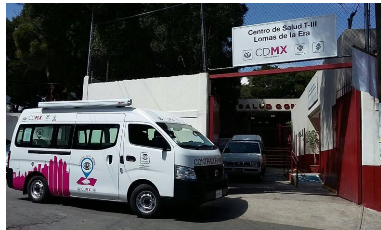
Imagen 2. Centro de Salud T-III de la Colonia Lomas de la Era antes del Sismo. Fuente: Secretaría de la Contraloría General CDMX. [ en línea]
