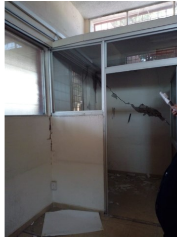
Imagen 11,12,13 y 14. Falla por cortante en los muros divisorios.
