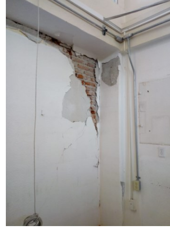
Imagen 10. Falla estructural en muro y losa, donde se puede ver reflejado en desprendimiento de los elementos al momento de trabajar en el sismo.
