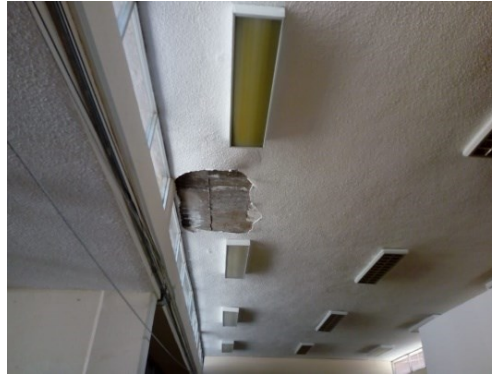
Imagen 9. Imagen de prueba en losa de azotea, la cual no sufrió daños representativos.
