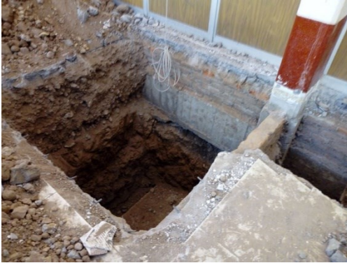
Imagen 8. Estudio realizado en sitio de la cimentación, la cual trabajó bien en el momento del sismo y no salió dañada.
