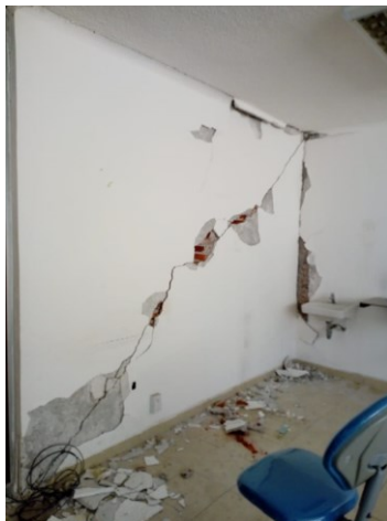
Imagen 11,12,13 y 14. Falla por cortante en los muros divisorios.
