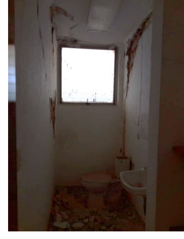
Imagen 10. Falla estructural en muro y losa, donde se puede ver reflejado en desprendimiento de los elementos al momento de trabajar en el sismo.
