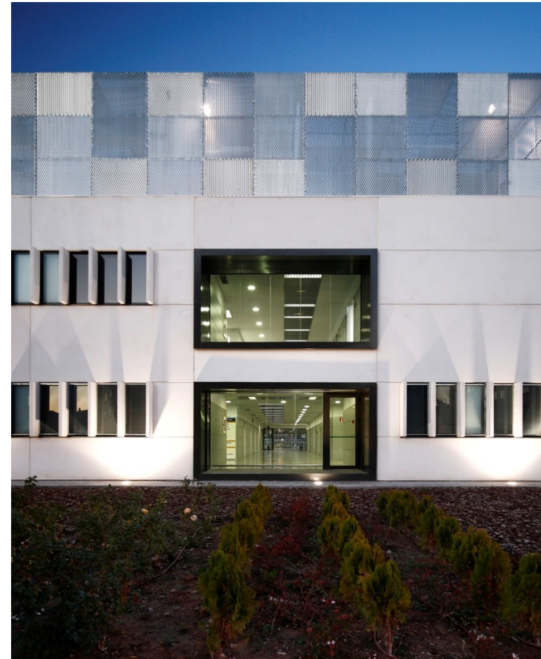
Imagen 32. Fachada posterior de Centro de Salud Ciudad Real 3/BAT+ARQUITECTICA
