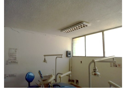
Imagen 10. Falla estructural en muro y losa, donde se puede ver reflejado en desprendimiento de los elementos al momento de trabajar en el sismo.
