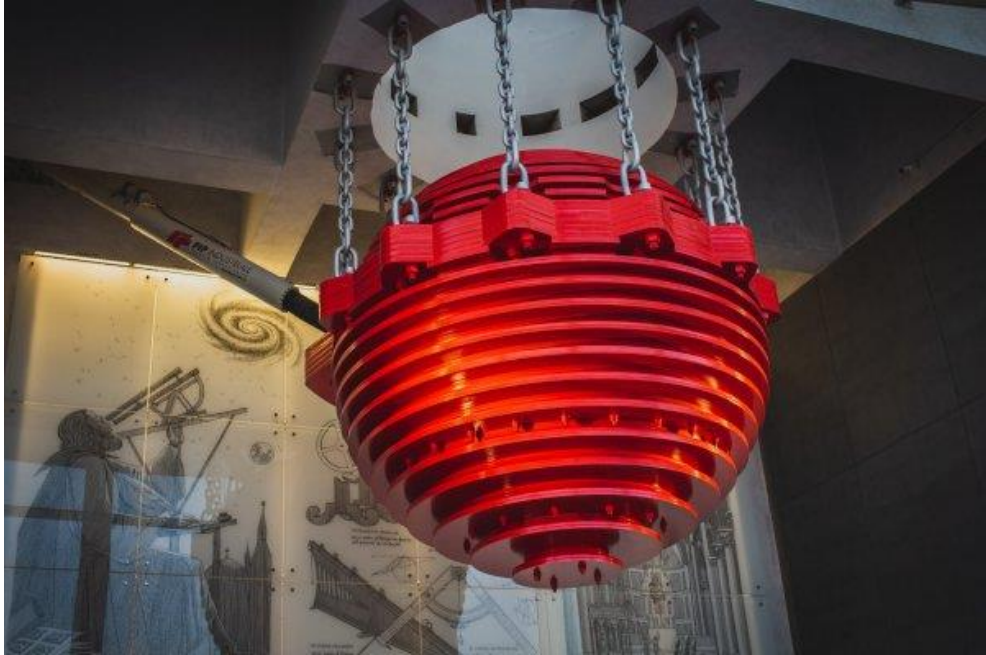
Figura 7. Amortiguador de masa sintonizada. (Fuente: CamaChilena de la Construcción).
