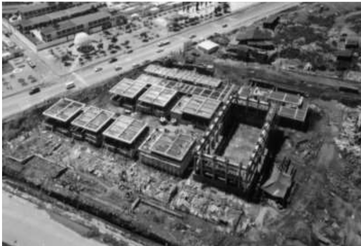
Imagen 3.20: Proceso de construcción.
