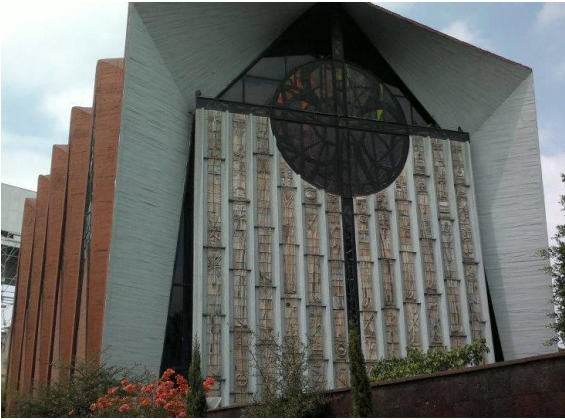
Ilustración 25: © Autor, fotografi.: Vista exterior del templo de San Antonio de Padua: Ritmo y modulación que además sostiene con estos dobleces, la cubierta, autores: Arq. Alberto Glez Pozo y Juan Antonio Tonda.
