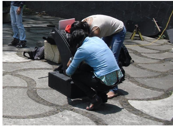
Fotografías Montaje de la estructura en “El patio de los huesitos” de la facultad de la arquitectura. No se aplicó la suficiente tensión pues la estructura no fue capaz de soportar las fuerzas que la tela se encontraba transmitiendo y la tela tampoco lo soportaría. Nótese en la imagen de abajo el cocido de cada malla, donde se ven los ojillos perimetrales que trae de fábrica el material
