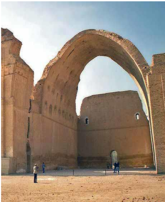
Ilustración 8: © Hassan M, "Taq Kasra in Baghdad, Iraq", 2018, Fotografía Palacio de Ctesifonte, Mesopotamia cerca de Bagdad, Irak. Siglo III DC, bóveda de cañón. Nótese el pronunciamiento que se da en el área donde se encontraría la clave, para mejorar su comportamiento estructural, https://es.wikipedia.org/wiki/Ctesifonte#/media/Archivo:Taq_Kasra.jpg
