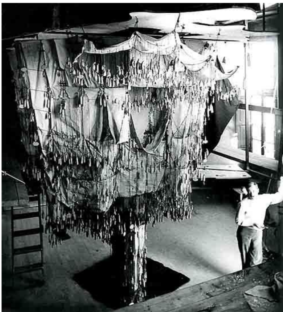
Ilustración 12: © Joan Bertrán, 1898-1908 “Maqueta Funicular para la Iglesia de la Colonia Güell. Barcelona. Antoni Gaudí.” Fotografía. https://upcommons.upc.edu/bitstream/handle/2099.1/19680/JordiSoler_TFM.pdf .
