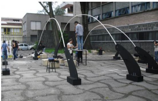
Ilustración 51: © Espinoza N., Torreblanca Mariscal S., García. J, Cervantes E., Fotografías Montaje de barras de PVC
