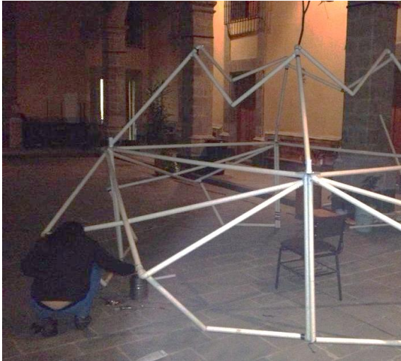
Ilustración 48: ©Gines Cabrera M, Villarreal A., Hernández G., Fotografías. Solución final de la estructura de PVC sanitario, nótese la manera de generar toda la estructura general para la estructura. Como colocar dos piezas de pvc para permitir que el nodo reciba todos los tubos o las piezas de conexión convencional fuera del nodo para codo y té de PVC.
