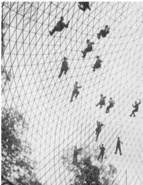
Ilustración 21: Uno de las primeras estructuras a base de ferrocemento: Zeiss Planetarium, Franz Dischinger. Arriba: Vista de la cúpula. Abajo: Maestros de obra trabajando en el armado de la cúpula, puede observarse la red que la varilla genera para tomar la forma indicada.
