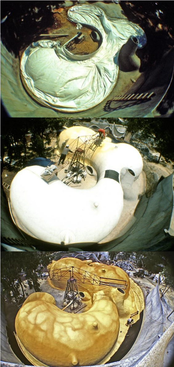
Ilustración 22: © Javier Senosiain Aguilar, fotos del proceso de obra del proyecto conocido como Ballena mexicana. El trabajo del arquitecto Senosiain no sólo está basado en el ferrocemento, influenciado por las estructuras de superficie activa (cascarones) también ha manejado el poliuretano espreado para sus estructuras.
