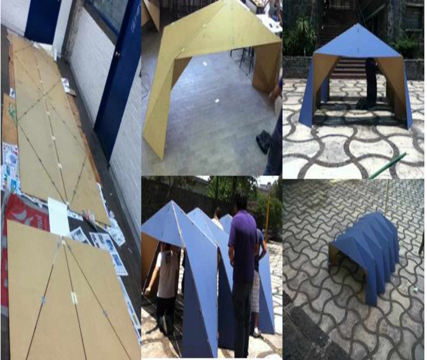
Ilustración 41: © Guerra Martínez Roberto Carlos, fotografías. Ensamble de las piezas de la estructura plegada, conexión de cada pieza, módulo y al final traslado al "patio de los huesitos" de la facultad de arquitectura
