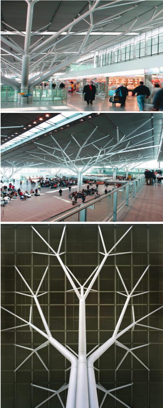
Ilustración 32: © Marcel Antonio Maury, Ilustración de la columna del Aeropuerto Internacional de Stuttgart, T3. Un ejemplo de estructura arborescente, el cual se comporta formal y estructuralmente como un árbol, procurando ligereza y levedad salvando claros considerables.
