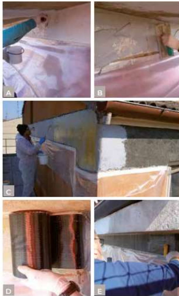
Figura 5. 19- Aplicación de las cintas de refuerzo de FRP (MAPEI, 2018).
