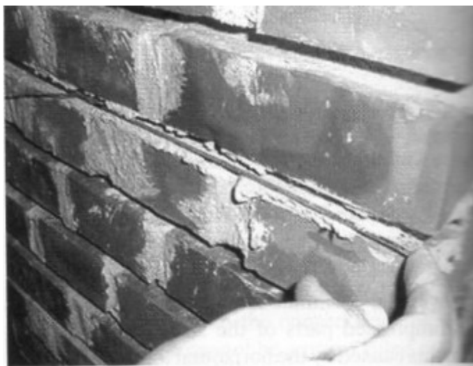
Figura 5. 20- Inserción de la cinta en la mampostería (Modena C., et al, 2005).
