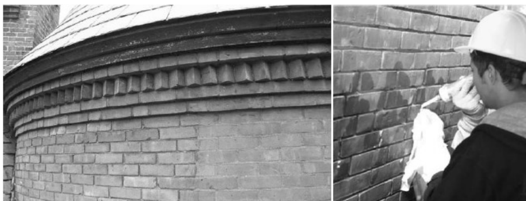
Figura 5.1- Sustitución de piezas dañadas (izquierda) y sellamiento de grietas (derecha). (Sanders et al., 2007).
