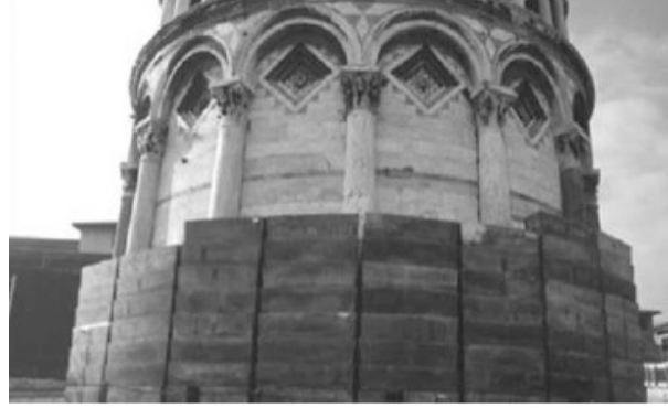
Figura 5. 29- Lastre de grandes bloques de plomo en la Torre de Pisa (Burghignoli A., 2003).
