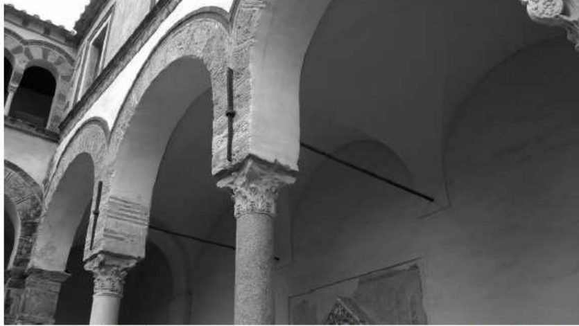
Figura 5.7- Ejemplos de antiguas barras de acero postensado en edificios italianos (De Guglielmo F, 2015).
