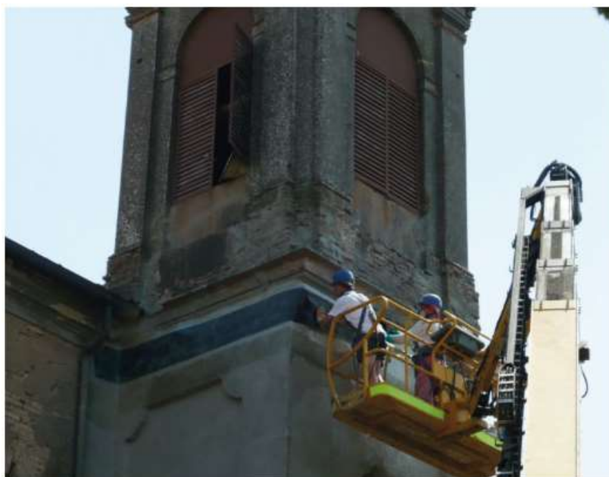
Figura 5. 17- Ejemplo de aplicación de la técnica de confinamiento exterior mediante cintas de FRP (www.mapei.com)
