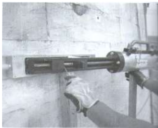
Figura 5.4- Tendones siendo tensados (Modena C., et al, 2005).
