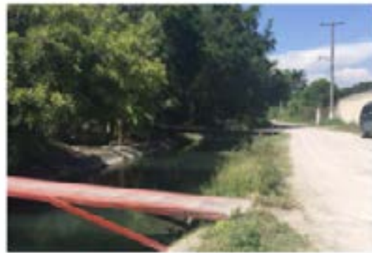
126 Puentes sobre el canal de riego
