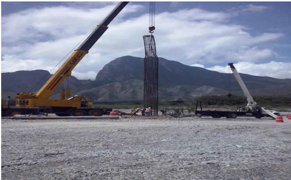
Imagen 5.9 Bajando el armado del pilote
