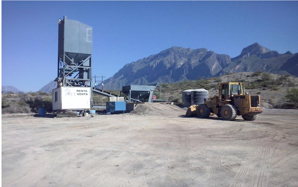
Imagen 5.2 Concretera y tolva para cemento suelto
