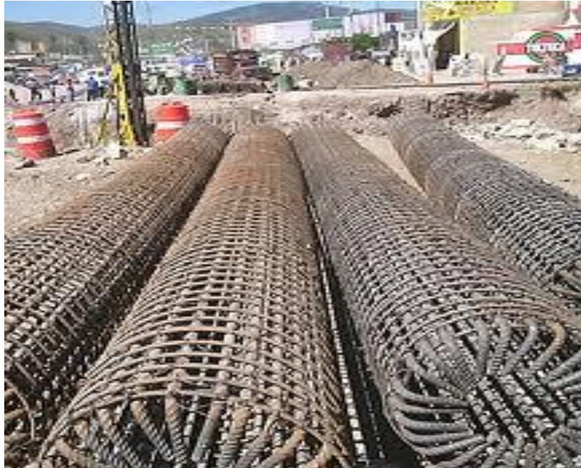
Figura 1.6.- Amado de pilotes para ser colados en el sitio
