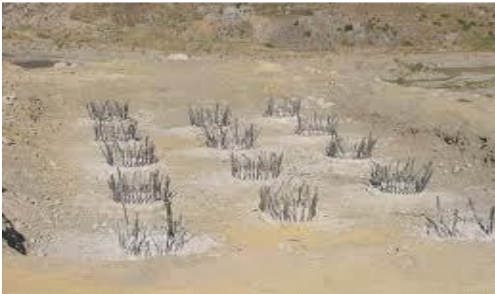
Figura 1.7.- Descabezado de un conjunto de pilotes.
