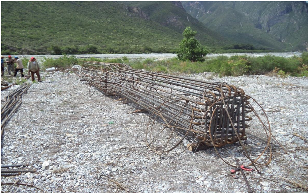
Imagen 5.7 Armado del pilote
