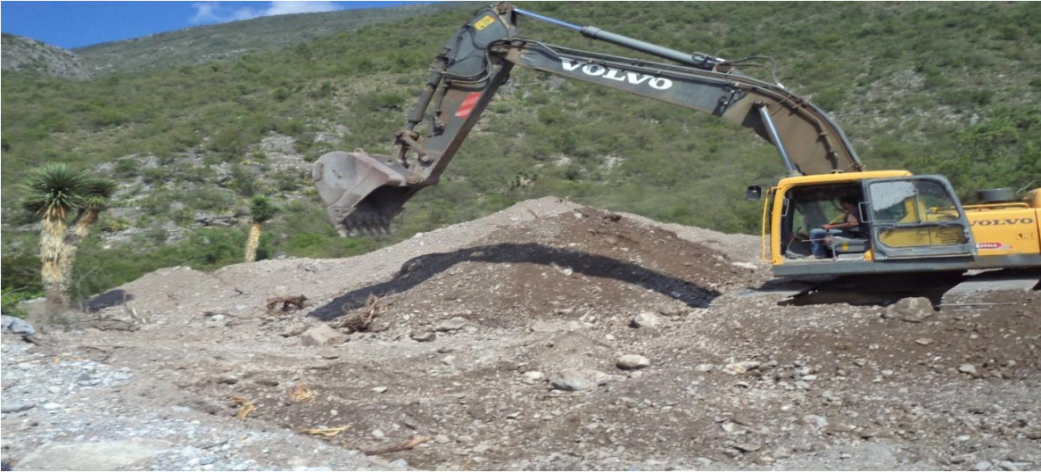
Fotografía 3.4 Inicio de excavaciones
