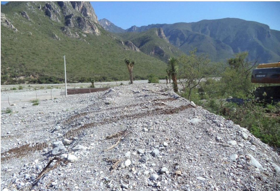
Fotografía 3.1 Sitio antes del inicio de los trabajos.
