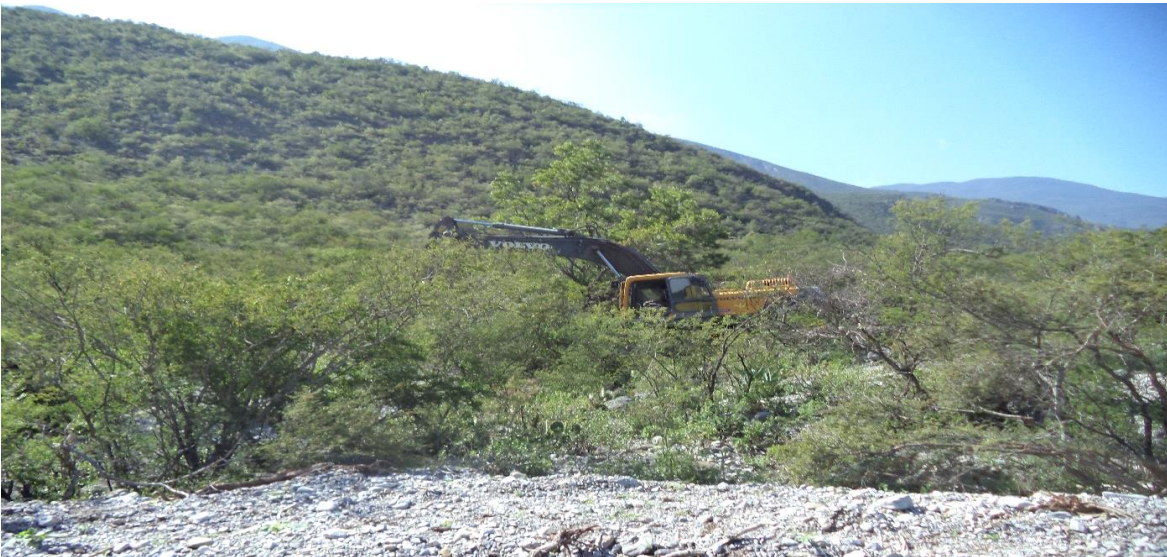
Fotografía 3.3 Inicio de los trabajos en el sitio
