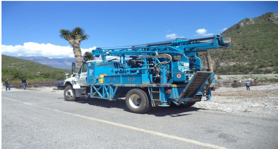
Imagen 5.5 Equipo de perforación para estudio de suelos
