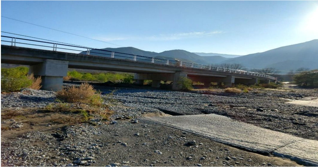
Imagen 5.10 puente terminado y en servicio
