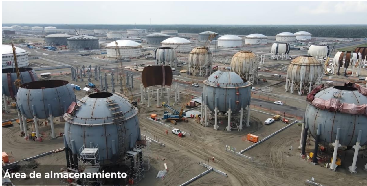
Figura 5.16 Construcción del Área de Almacenamiento en Refinería Olmeca. (SENER, 2021).
