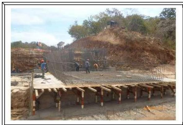
Imagen. 107 Armado en dovela de orilla E-1, nótase el volado en la parte frontal, para insertar la cimbra para el cierre.
