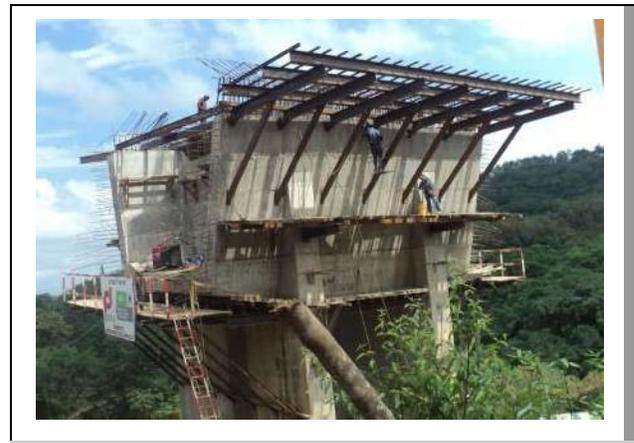
**Imagen. 55 Losa de fondo y armado en dovela sobre pila A3.**
