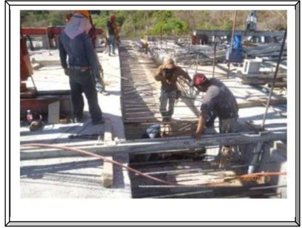
**Imagen. 115 Colocación y suspensión de cimbra mediante barras y viguetas.**
