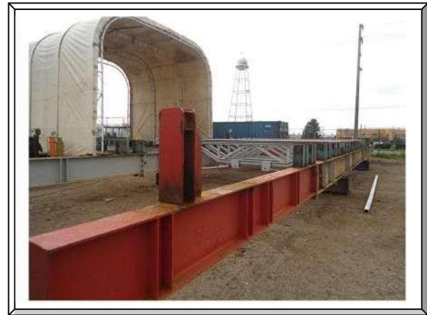
**Imagen. 156 Ensamble de plataforma inferior en taller.**
