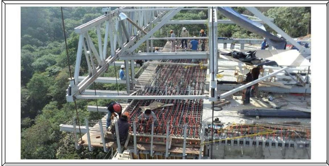
**Imagen. 85 Armado de Dovela.**
