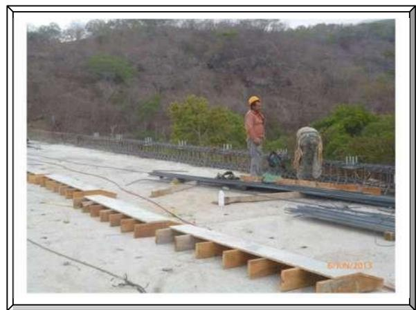
**Imagen. 143 Armado de guarnición y placas en parapeto.**
