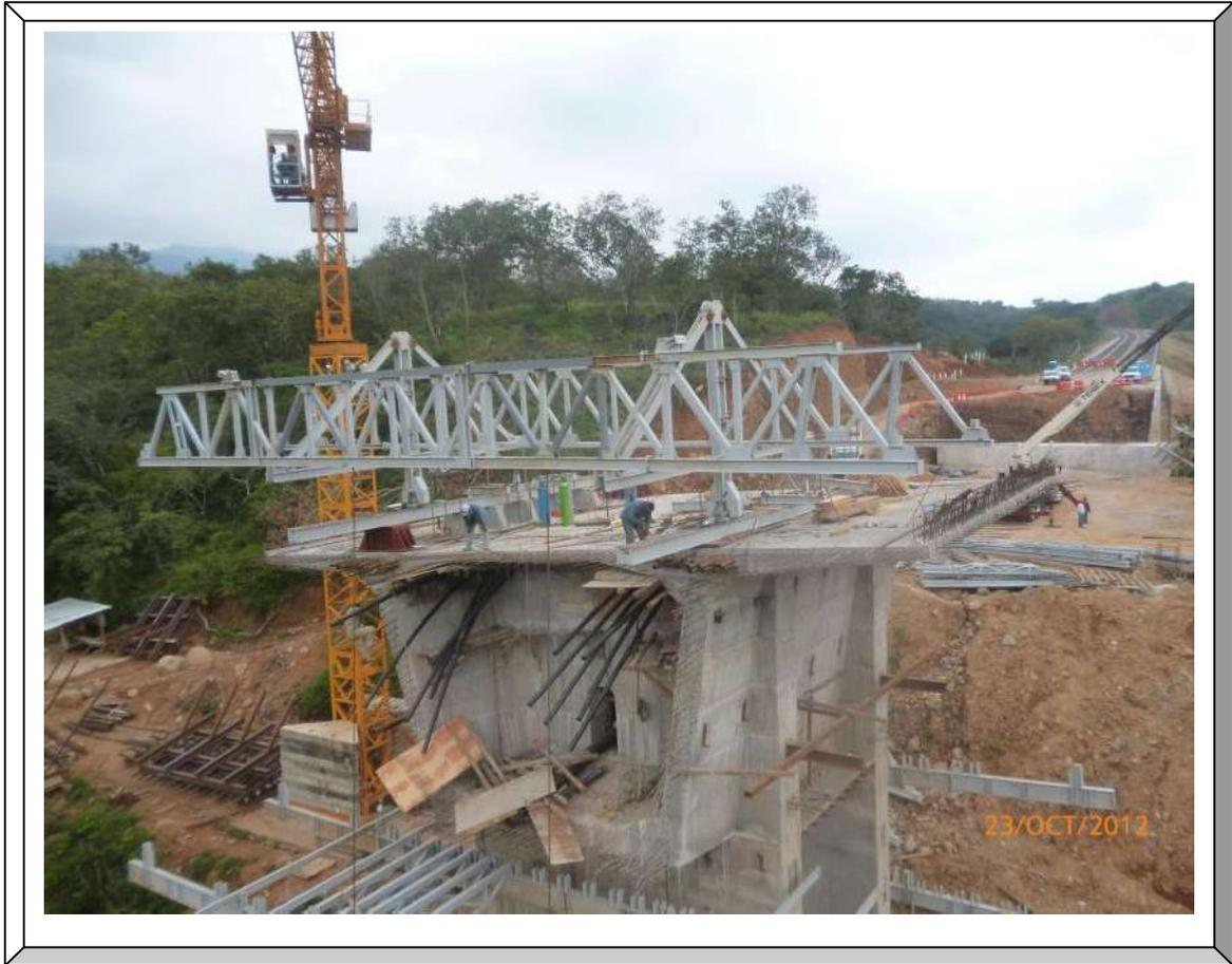
**Imagen. 65 Montaje de triángulo y cerchas.**
