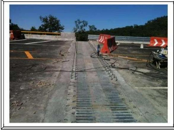
**Imagen. 147 Tensado y corte de anclaje de tensión.**
