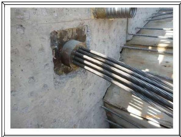
**Imagen. 93** Tendón de presfuerzo en dovelas.
