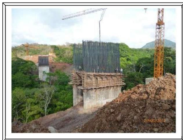
Imagen. 48 Obra falsa para dovela sobre pila A2.
