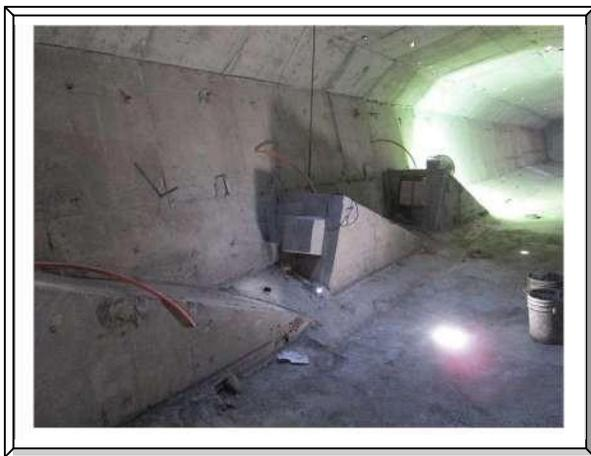
Imagen. 126 Bloques de anclaje para cables 407-i, 408-i 409-i en dovelas D12, D13 y D14.
