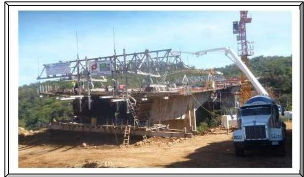
**Imagen. 89 Posicionamiento de Bomba telescópica.**
