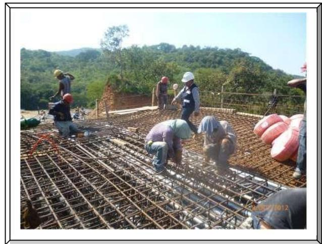
**Imagen. 57 Colocación de ductos para presfuerzo en dovela sobre pila A3.**
