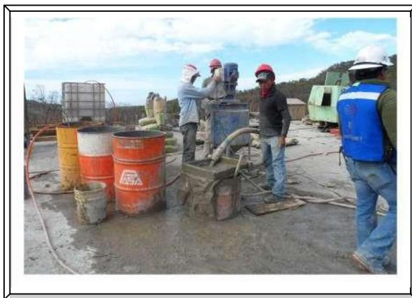
**Imagen. 128 Preparación de lechada con mezcladora.**
