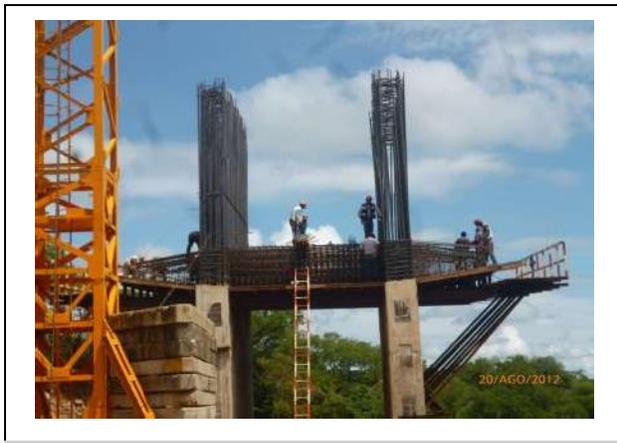
**Imagen. 54 Losa de fondo y armado en dovela sobre pila A3.**
