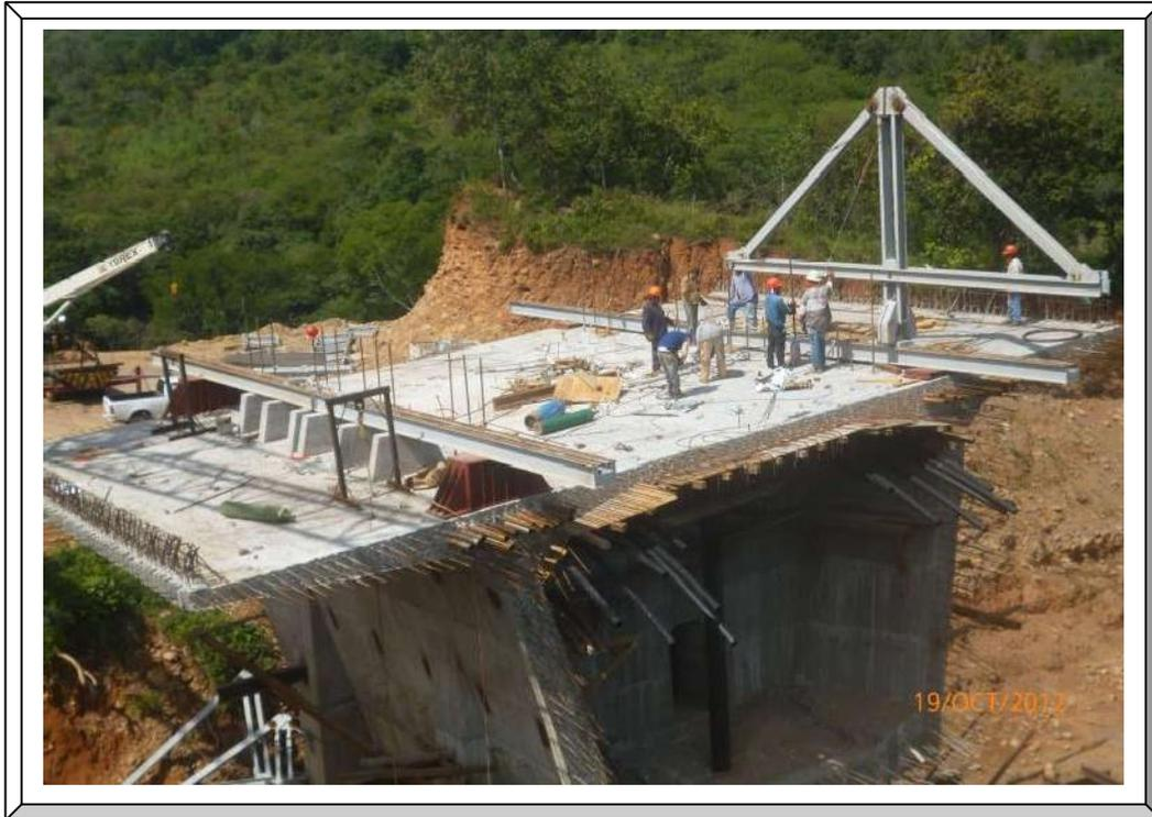
**Imagen. 64 Montaje de rieles y triángulo.**
