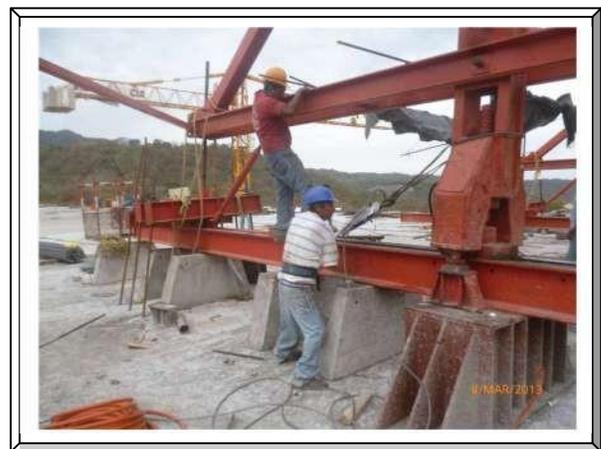
**Imagen. 102** Levantamiento de carro y corrimiento de viga.
