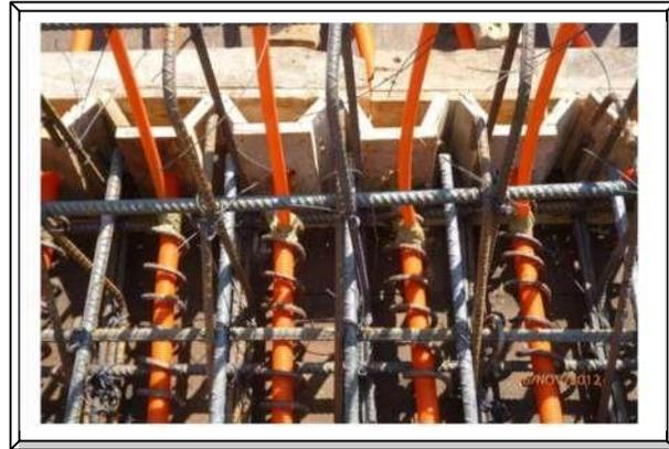
**Imagen. 79** Configuración de Cables.
