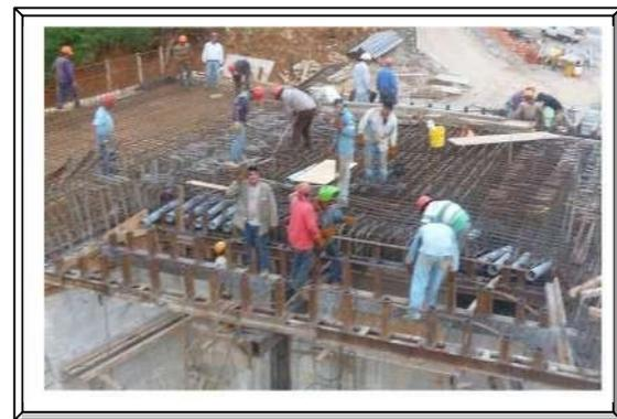
**Imagen. 83** Tubos desviadores en dovela sobre pila.
