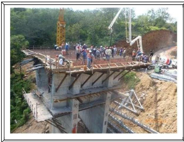
**Imagen. 56 Colado de dovela sobre pila A3.**
