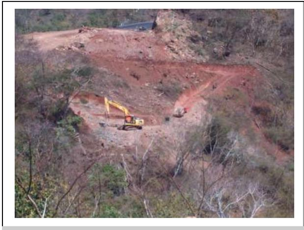
Imagen. 34 Excavación Zapata 2
