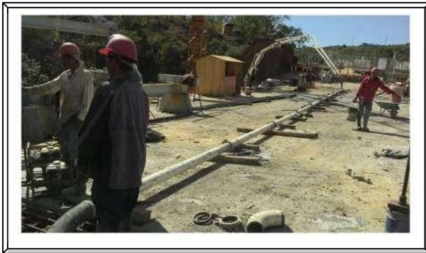
**Imagen. 88 Colocación de línea de bombeo de concreto.**
