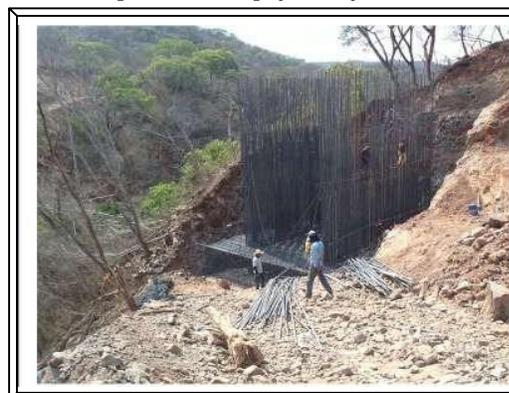
Imagen. 41 Armado Zapata 2.
