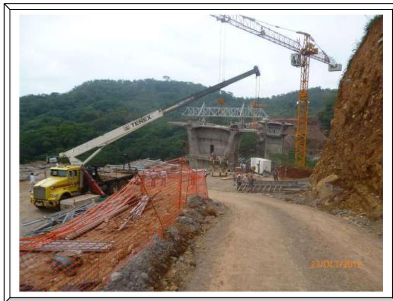
**Imagen. 159 Armado de carro de colado.**
