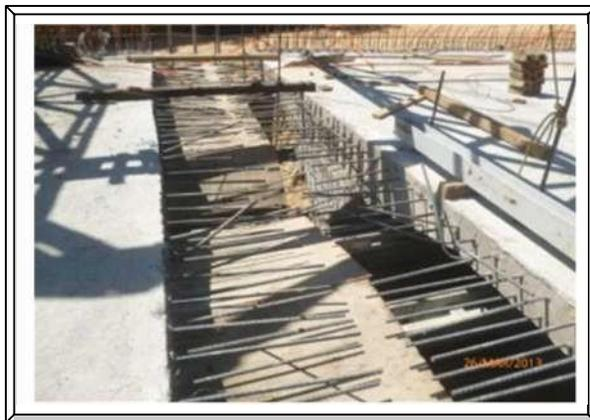
**Imagen. 111** Se ha retirado un carro, lado derecho para que el del lado izquierdo entre en la dovela.
