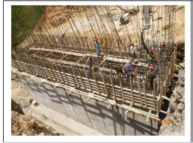
**Imagen. 51 Colado de muros en estribo E4.**
