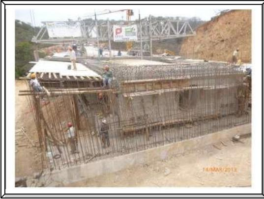
**Imagen. 108** Cimbra de losa superior en dovela de orilla.
