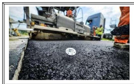
Imagen. 14 Revisión de Temperatura de asfalto.
