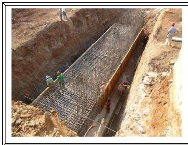
Imagen. 44 Armado de Estribo. 1
