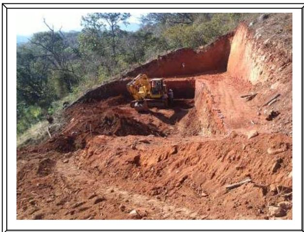
Imagen. 36 Excavación de Zapata 2
