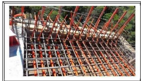
**Imagen. 87 Ductos para presfuerzo transversal.**
