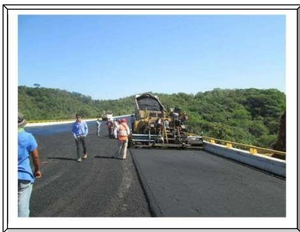
**Imagen. 134 Colocación de carpeta asfáltica con extendedora.**
