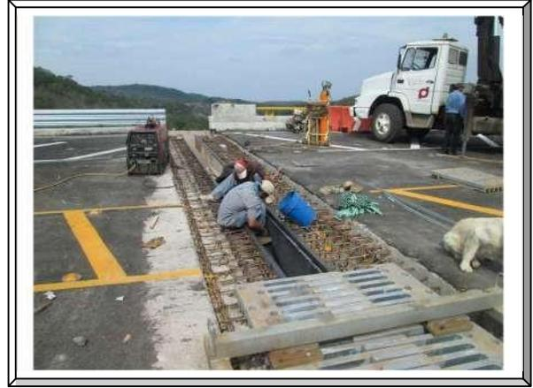
**Imagen.148 Colocación de Junta y membrana de elastómero.**
