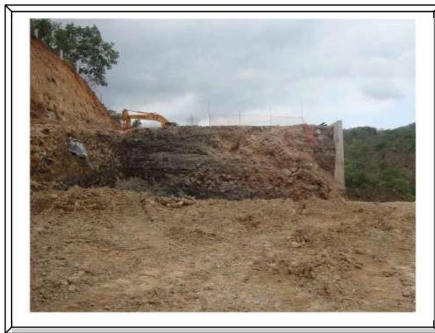
**Imagen. 39** Excavación de Estribo 1.
