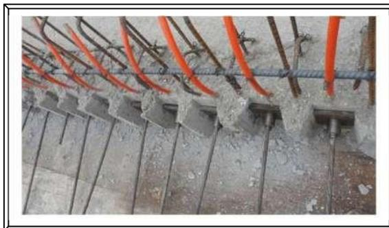
**Imagen. 86 Vista lateral del presfuerzo transversal.**
