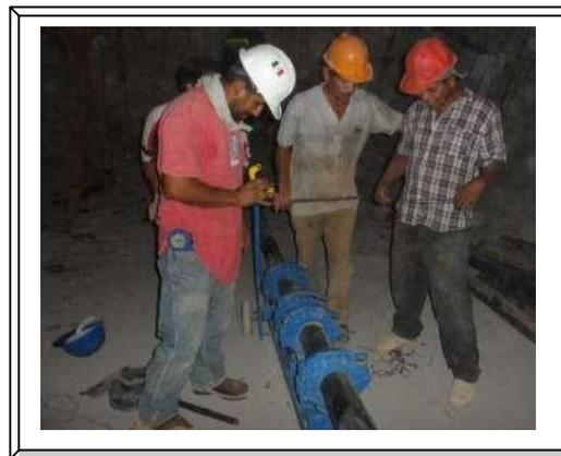
**Imagen. 164 Equipo de termofusión.**
