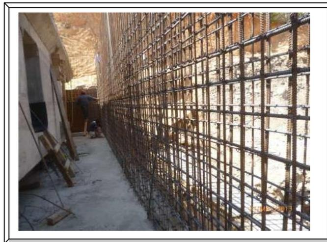
**Imagen. 131 Muros de respaldo de estribos.**
