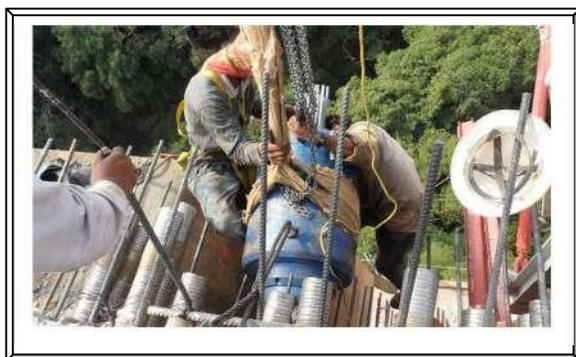
**Imagen.160 Gato de tensado 500 ton.**
