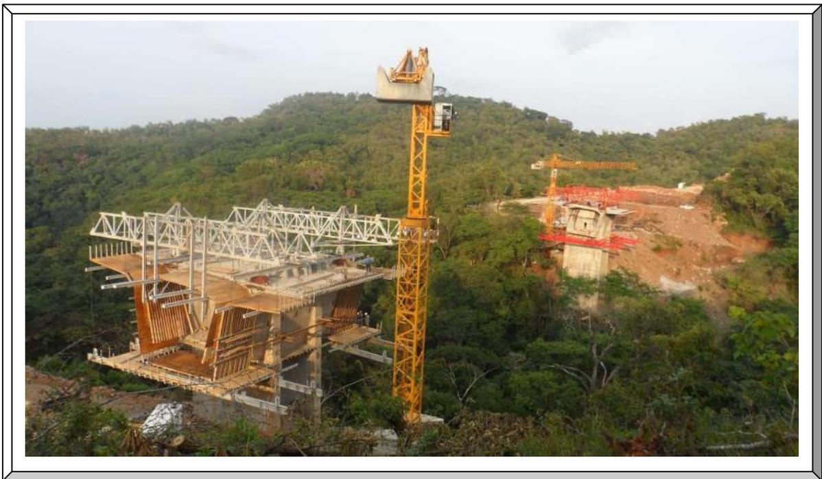
**Imagen. 68 Montaje de cimbra interior en carro de colado.**
