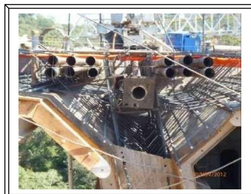
Imagen. 75 Configuración de Cables.
