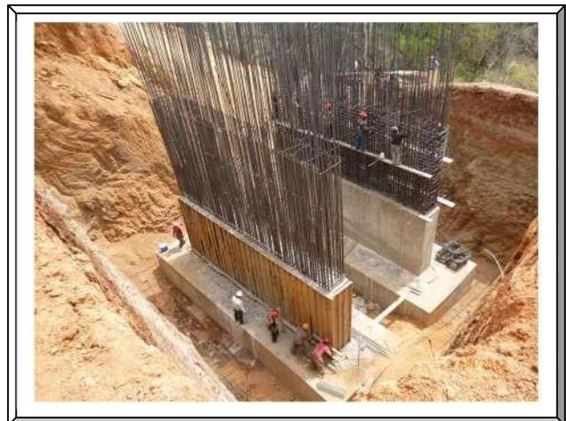
Imagen. 47 Cimbra y armado de acero de refuerzo pila 3.
