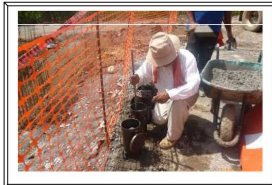
Imagen. 12 Preparación de cilindros de concreto.
