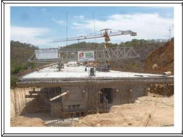
Imagen. 117 Muro diafragma en dovela de orilla E4.
