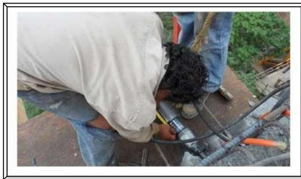
**Imagen. 95 Tensado de presfuerzo transversal.**
