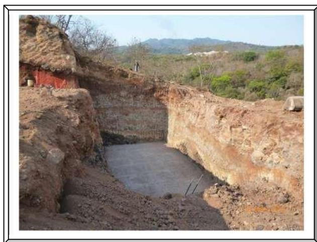
**Imagen. 38** Excavación de Estribo 1.
