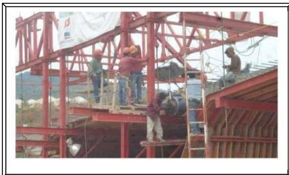
**Imagen. 97 Tensado de presfuerzo longitudinal.**
