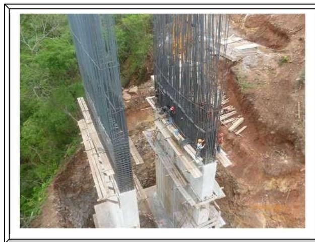
Imagen. 49 Armado de acero de refuerzo en pila A2.
