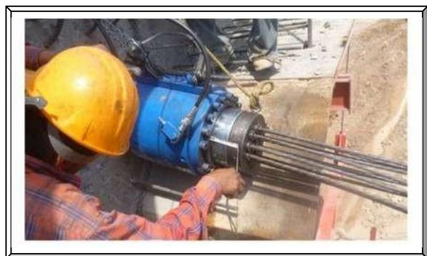
**Imagen. 98 Tensado de presfuerzo Longitudinal.**
