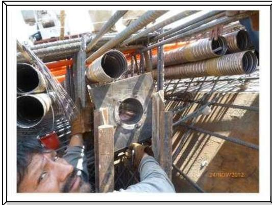
**Imagen. 91** Trompeta y respiradero en ducto engargolado.
