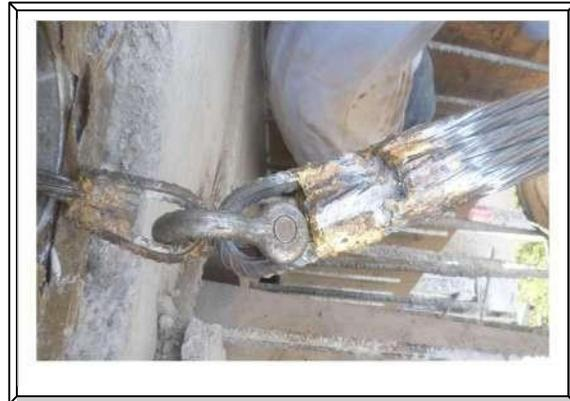
**Imagen. 92** Preparación en tendón de presfuerzo.
