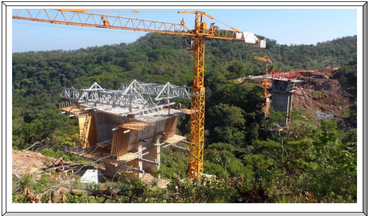
**Imagen. 67 Montaje de cimbra exterior en carro de colado.**
