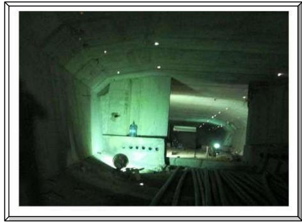
Imagen. 118 Bloques desviadores para el presfuerzo longitudinal.
