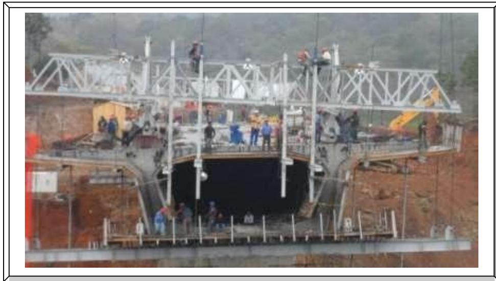
**Imagen. 100** Descenso de carro, soltando barras de presfuerzo.
