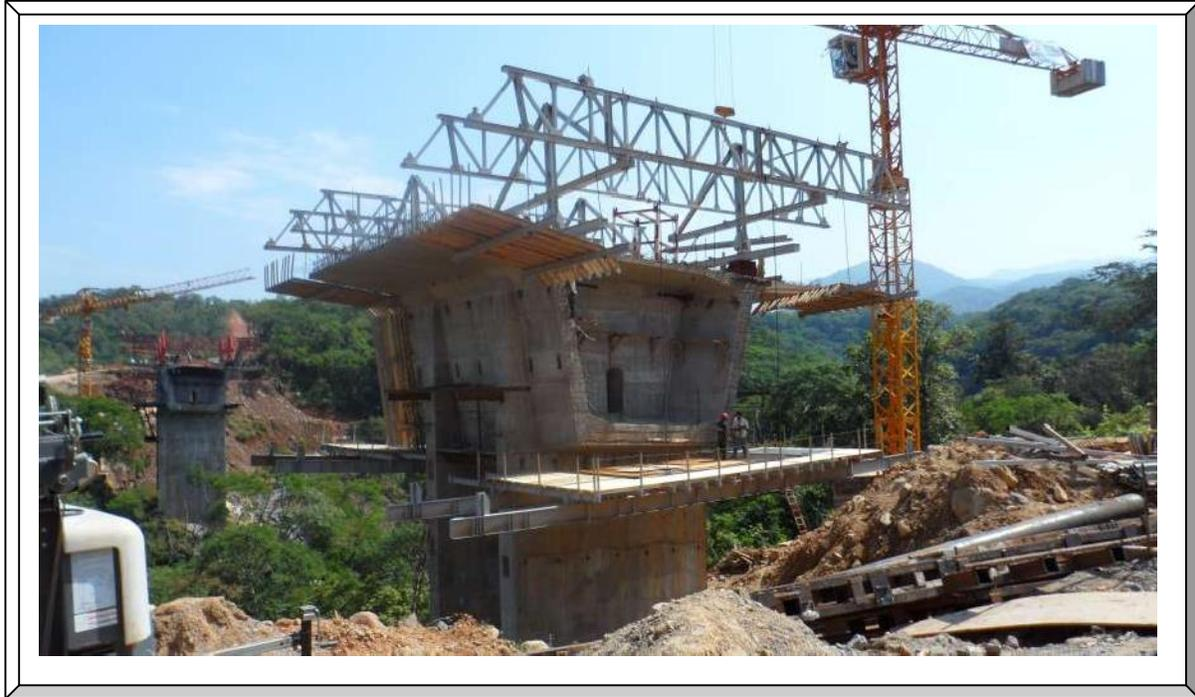
**Imagen. 66 Montaje de plataformas inferiores.**
