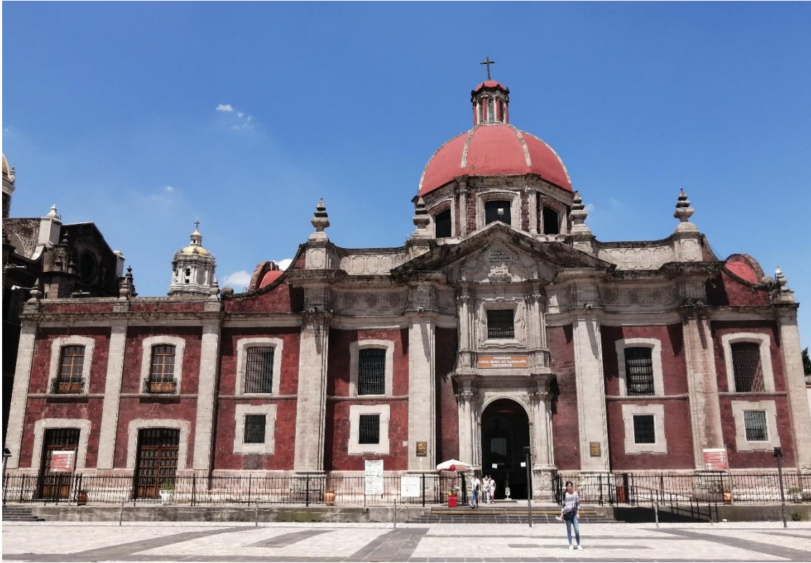
Figura 13: Iglesia y Ex Convento de Las Capuchinas (Fuente: trabajo de campo, 2021).
