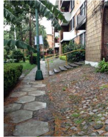
Imagen 50 Accesos a edificio AAB con escaleras. Fotografía propia (2020).
