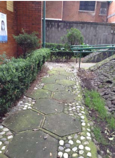
Imagen 71 Andador. Fotografía propia (2020) Final de recorrido de rampa. En la imagen se observa parte del edificio EJ.
