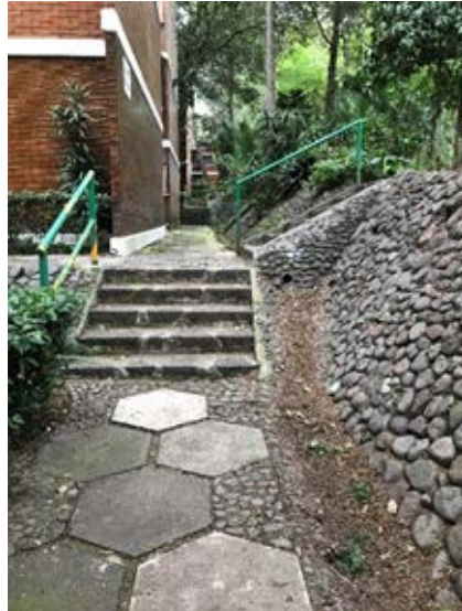
Imagen 64 Escaleras. Fotografía propia (2020)
