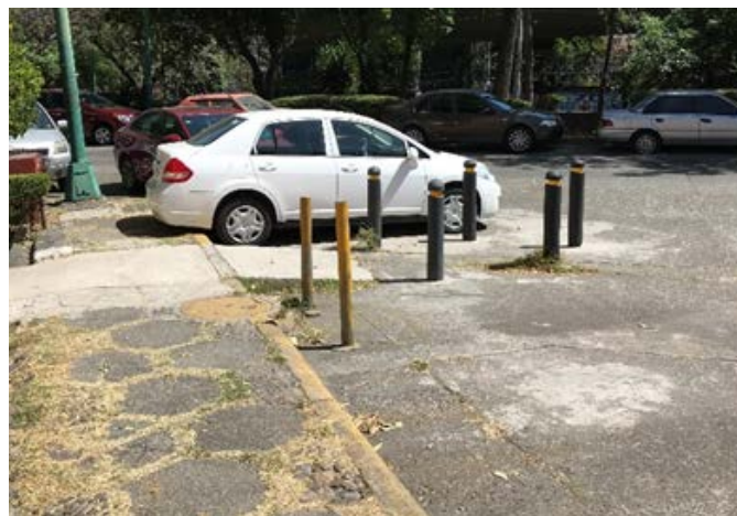
IMAGEN 18 Rampa hacia estacionamiento. Fotografía propia (2020) En la imagen se ve parte del andador.
