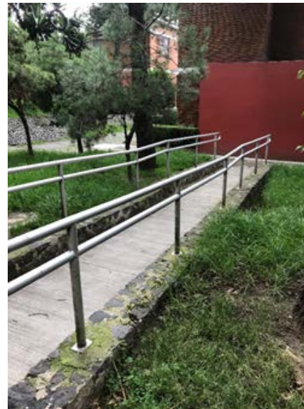
IMAGEN 34 Rampa. Fotografía propia (2020)
