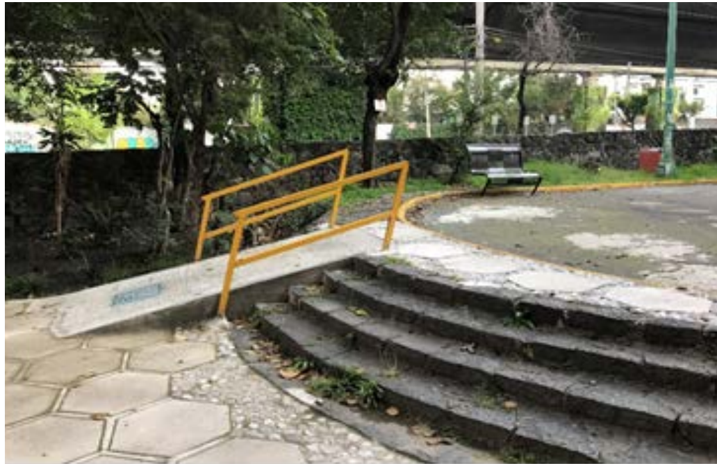
Imagen 123 Rampa instalada recientemente. Fotografía propia (2020).
