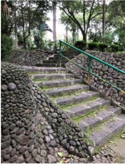
Imagen 63 Escaleras. Fotografía propia (2020)
