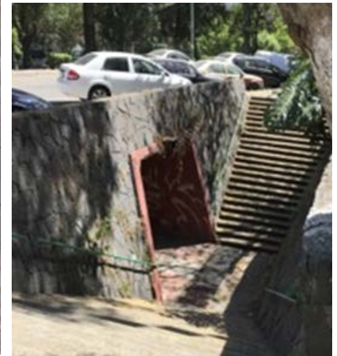
IMAGEN 22 Desnivel con escaleras. Fotografía propia (2020).
