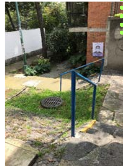
Imagen 115 Escaleras en andador. Fotografía propia (2020)
