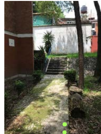
Imagen 85 Andador en mal estado. Fotografía propia (2020)
