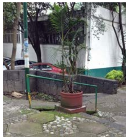
Imagen 69 Escaleras y rampa hacia la tienda del IMSS. Fotografía propia (2020).
