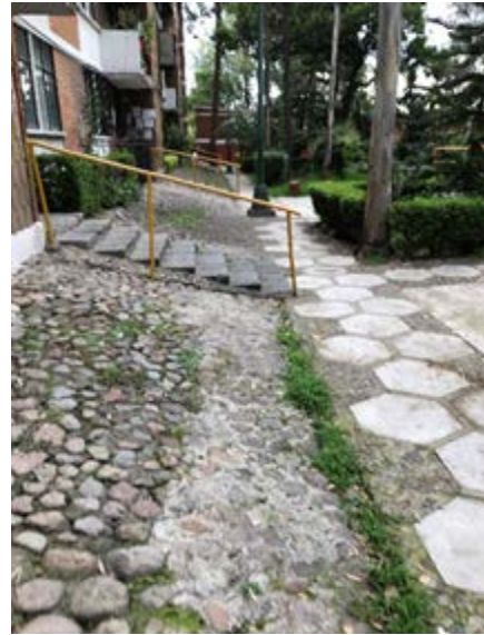
Imagen 37 Escaleras a edificio AAB. Fotografía propia (2020)
