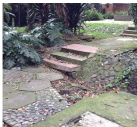
Imagen 68 Escaleras a viviendas dúplex. Fotografía propia (2020)
