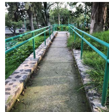
IMAGEN 19 Rampa desde Circuito Independencia hacia la zona de Torre Uxmal. Fotografía propia (2020)
