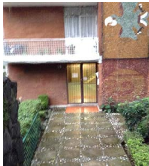
Imagen 101 Vista de acceso a edificio C.J. Fotografía propia (2020).
