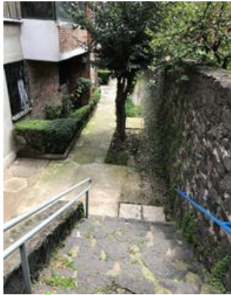
Imagen 93 Escaleras. Fotografía propia (2020)
