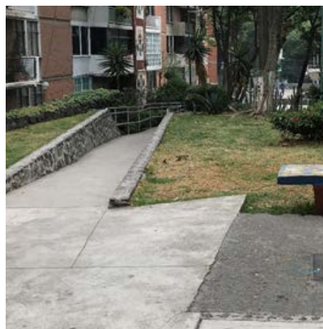
Imagen 83 Rampa. Fotografía propia (2020)
