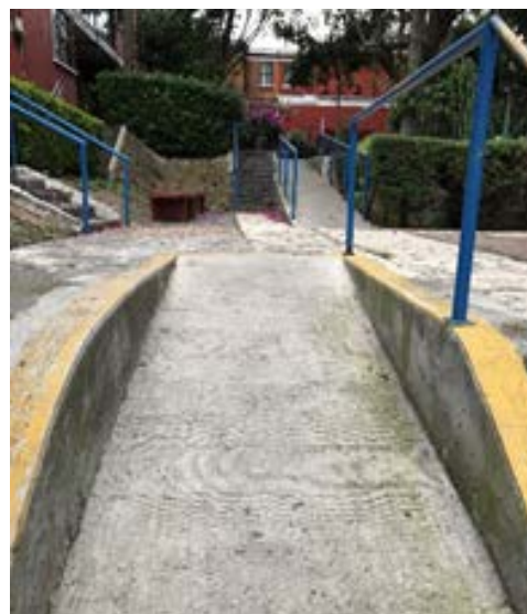
Imagen 104 Rampa. Fotografía propia (2020)
