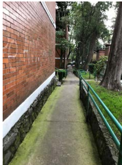
Imagen 61 Rampa. Fotografía propia (2020)
