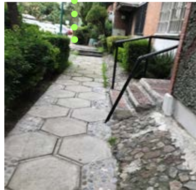
IMAGEN 27 Andador y acceso . Fotografía propia (2020)
