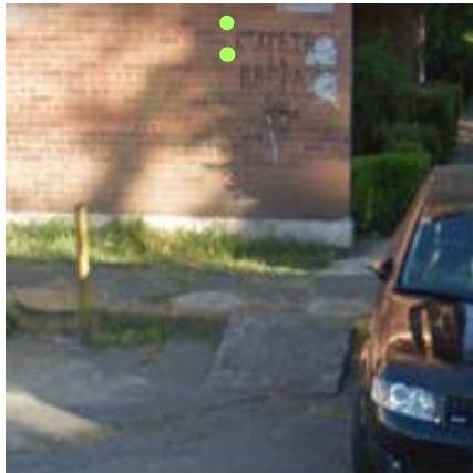
IMAGEN 28 Rampa . Fotografía propia (2020)
