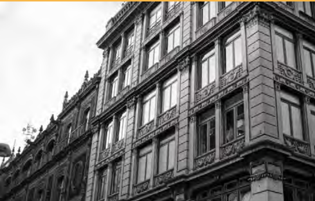
Fig 62 Edificio de la Ciudadela sede de la EDA en 1962.
