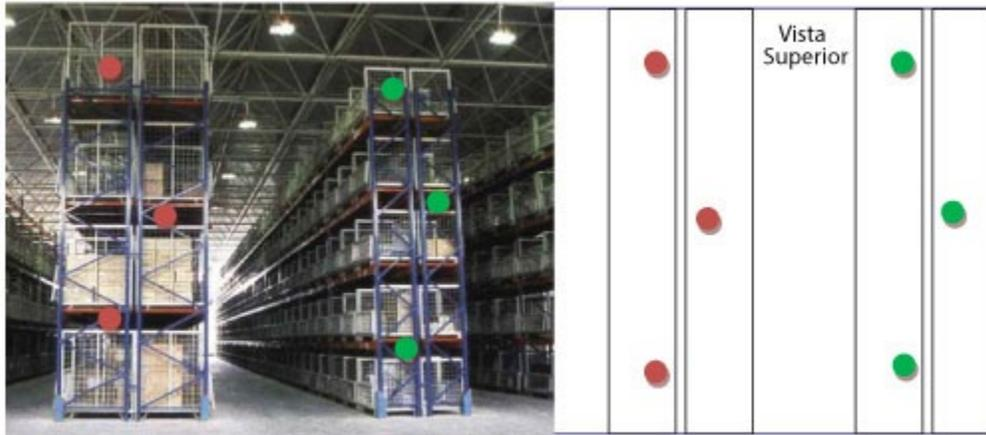
Figura 27 - Sensores colocados en el centro de los soportes, reflejan con mayor precisión las temperaturas de los productos. En este ejemplo, nueve sensores están ubicados en cada soporte doble de este almacén, midiendo 30 metros por 30 metros por 15 metros
