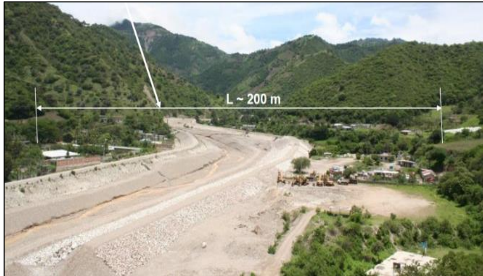
Figura 3- 18 En esta figura se puede observar un puente para cruzar el río, sus dimensiones son de 80 m. También se puede notar el asolvamiento del río. La población cercana al río cubre 200 m de su margen y en caso de un desbordamiento serían los primeros afectados.
