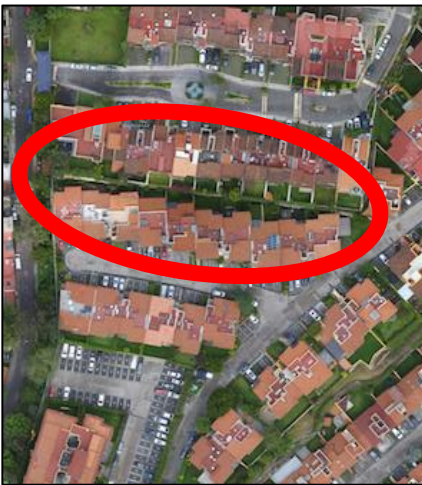
Figura 3- 8 Identificación de área de riesgo.
