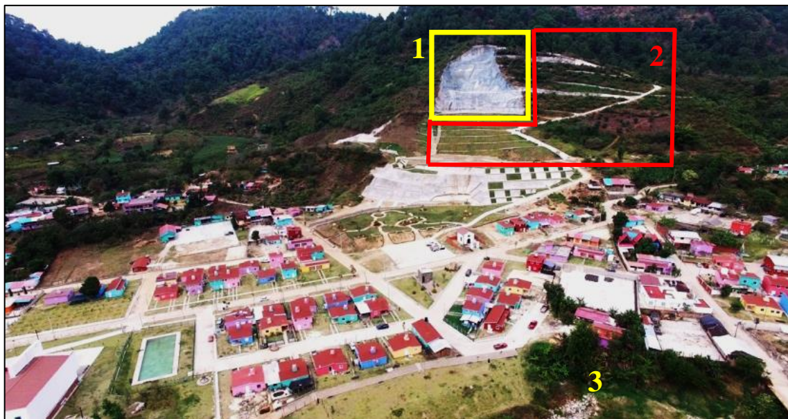
Figura 3- 30 La Nueva Pintada, Guerrero, se pueden distinguir las obras de mitigación en la ladera afectada, contención de masa con recubrimiento de concreto (1). Se plantó vegetación (2) con el fin de absorber la humedad de la tierra y las viviendas fueron reubicada (3).
