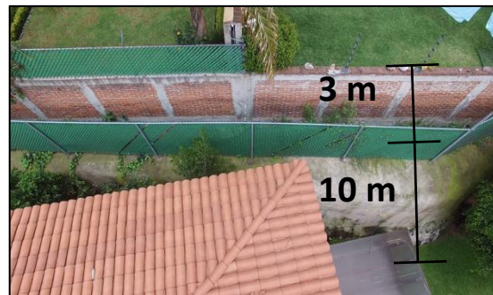
Figura 3- 9 Altura de talud y pared perimetral.
