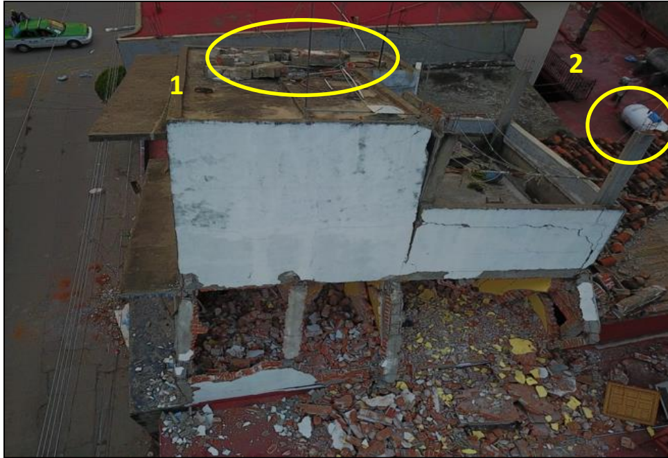
Figura 3- 21 Vivienda colapsada en Juchitán, Oaxaca. Se observa peso muerto (1) del lado del colapso y un tanque de gas LP (2) en la casa de atrás.
