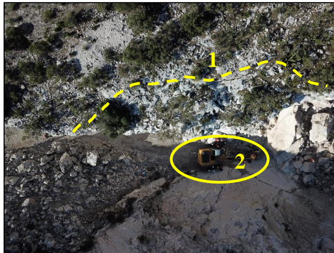
Figura 3- 11 Mina de mármol en Dengantzha, municipio de Mixquiahuala de Juárez, Hidalgo. Se identificó una grieta en la pared norte de la mina (1) justo por encima de las maniobras de rescate (2). Se informó al comandante de operaciones de socorro.
