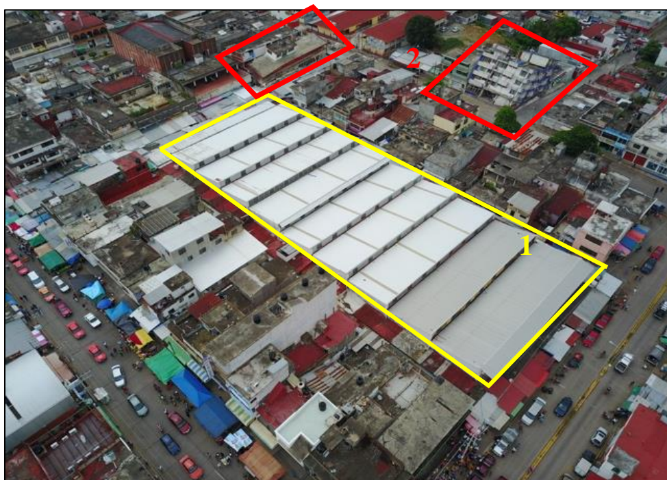
Figura 3- 27 Mercado de la comunidad Matías Romero, Oaxaca. Se descartó daño en el techo de lámina (1), estructuras colapsadas en la periferia del mercado (2). Con una adecuada señalización y delimitación de un perímetro de acercamiento no representa peligro para los compradores.
