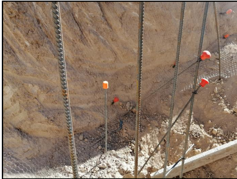
Fig. 29. Colocación de capuchones para puntas expuestas.
