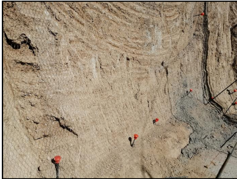
Fig. 27. Colocación de malla de protección contra derrumbe.
