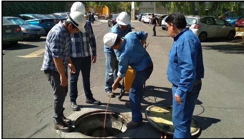
*Figura 66 Tendido del cable de fibra óptica.*
