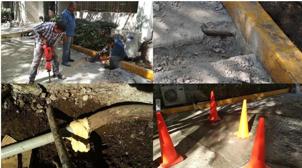
*Figura 67 Dificultades experimentadas en el tendido del cable de fibra óptica.*
