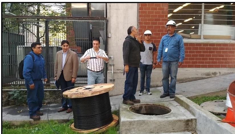
*Figura 65 Inicio del tendido del cable de fibra óptica.*
