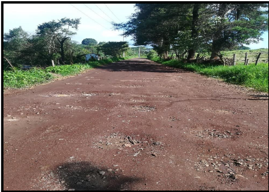
Imagen 3.14. Condiciones actuales del camino.
