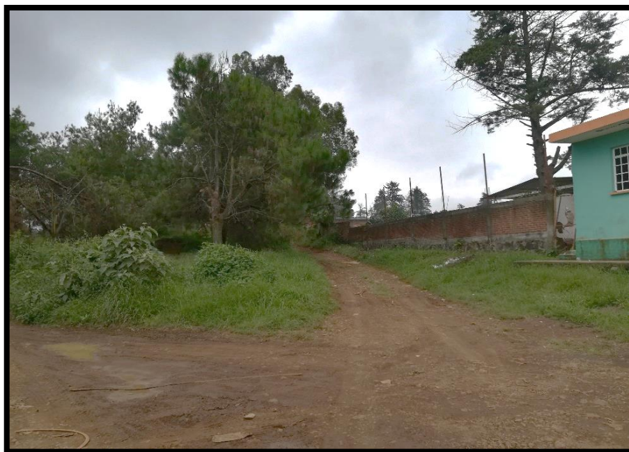
Imagen 3.15. Condiciones actuales del camino.
