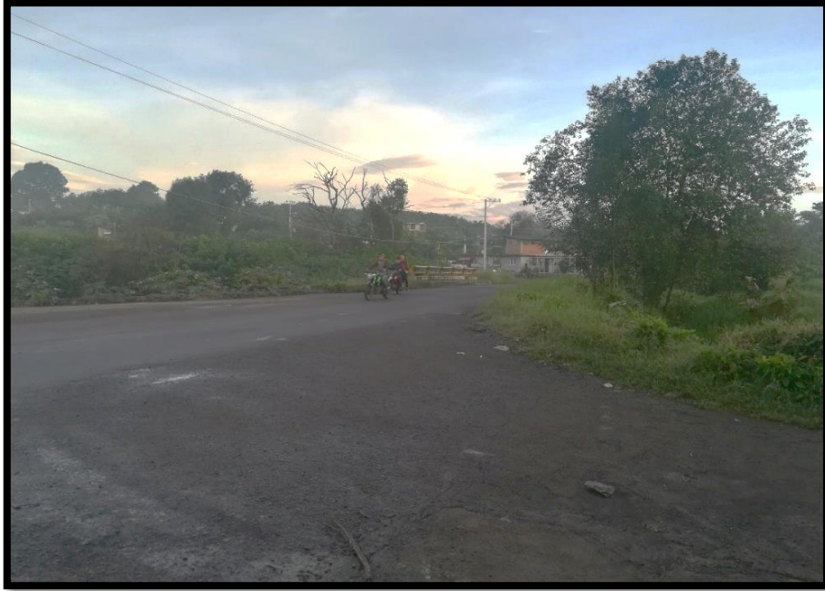
Imagen 3.7. Avenida Santa Rosa, camino principal.
