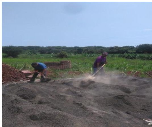
Imagen 3.5 Limpieza del terreno y mejoramiento del mismo
