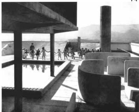
Levantada sobre la hierba en medio de un extenso parque de 3 hectáreas y media, bañada de luz y sol, l'Unité d'Habitation se orienta este-oeste y carece de aberturas al norte, lado del mistral. Medidas: 165.0m de longitud, 24.0m de profundidad, 56.0m de altura. El edificio está construido sobre *pilotis*. El suelo queda libre y consagrado a los peatones. Hay un estacionamiento para automóviles y vías reservadas para las bicicletas. [64] [65] [66] [71]
