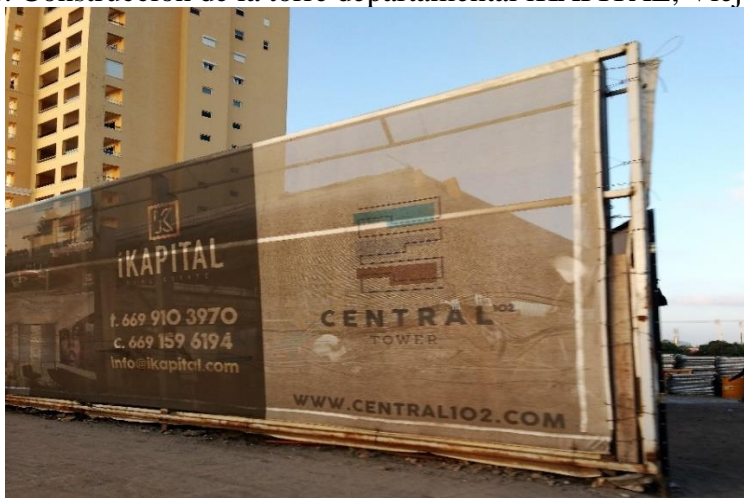
Figura 5.8. Construcción de la torre departamental iKAPITAL, Viejo Mazatlán
