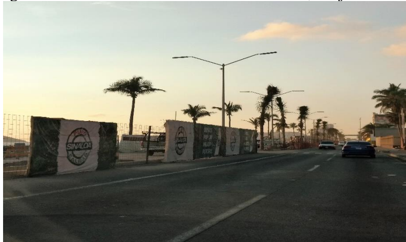
Figura 5.7. Obras de remodelación del malecón, Viejo Mazatlán
