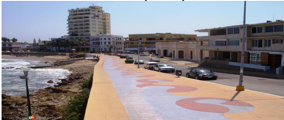
3.34. Remodelación de las banquetas en paseo Claussen, 2005
