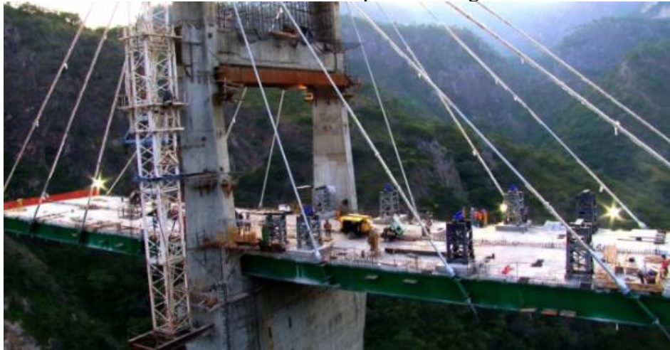
3.33. Construcción de la autopista Durango-Mazatlán
