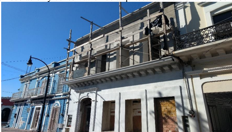
Figura 5.10. Remodelación y conservación de arquitectura tradicional del Centro de la Ciudad
