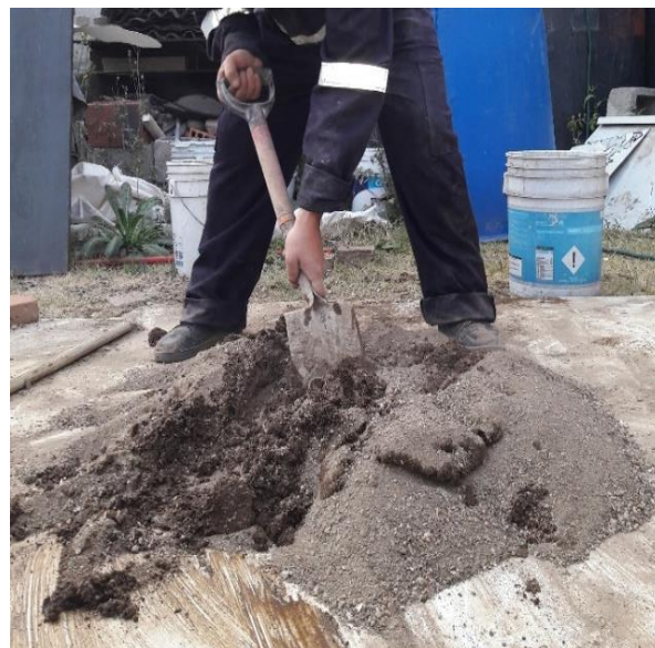
Figura 50: Hidratado de materiales Fuente: Imagen propia
