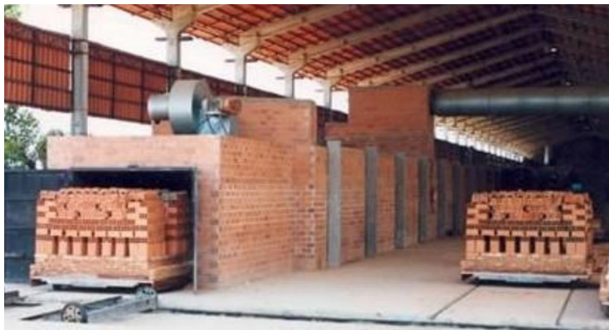
Figura 17: Horno de túnel, producción continua
