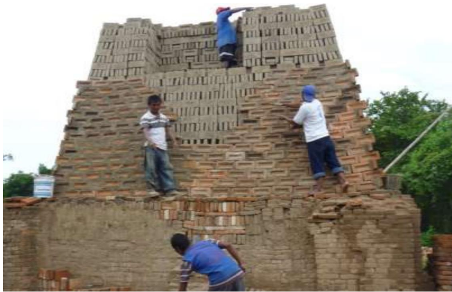
Figura 9: Horno tradicional en fase de carga y acomodo de ladrillos en ladrillera artesanal Fuente: Vivianco, 2011
