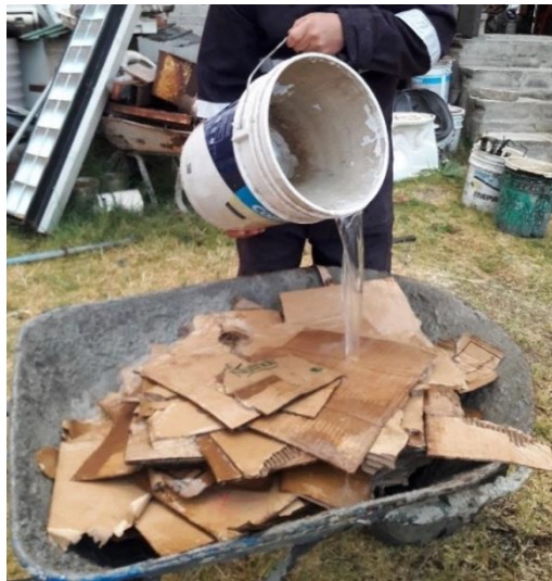
Figura 46: Humedecimiento de cartón Fuente: Imagen propia
