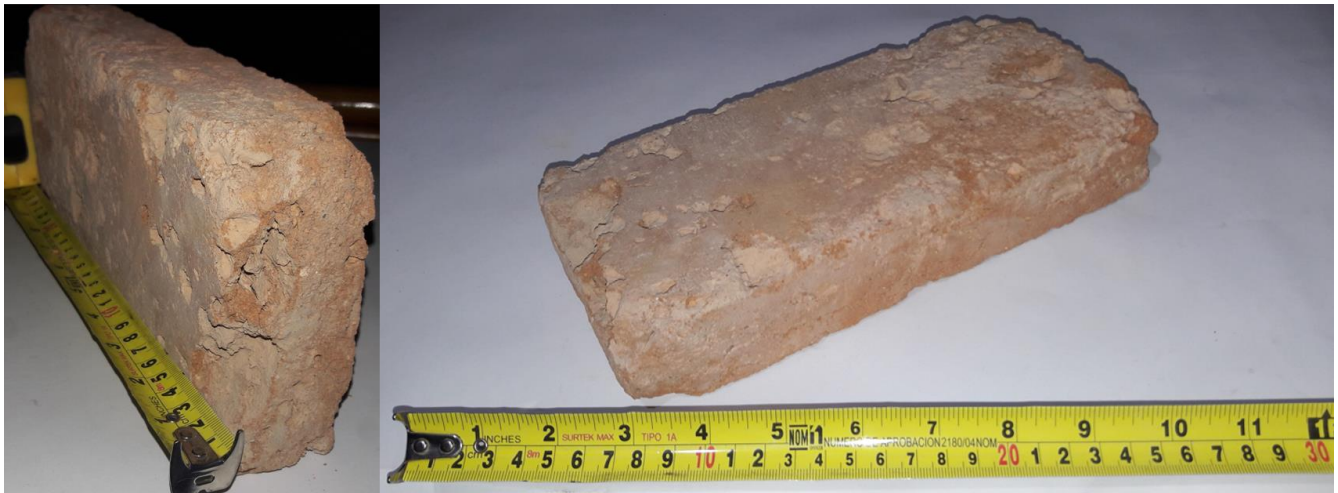
Figura 6: Ladrillo fuera de tolerancia a las despostilladuras Fuente: Imagen propia
