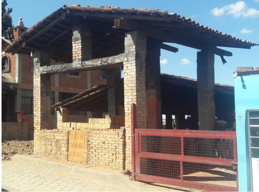
Figura 15: Horno de tiro superior, producción intermitente Fuente: Imagen propia
