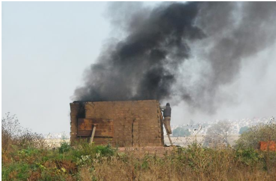
Figura 2: Horno ladrillero convencional en operación Fuente: Romero, 2016
