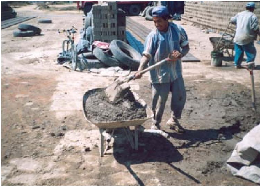
Figura 11: Preparación de la pasta Fuente: Ibarra, 2004
