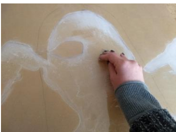
4.- Usando lija de papel, lijamos el área a pintar.
