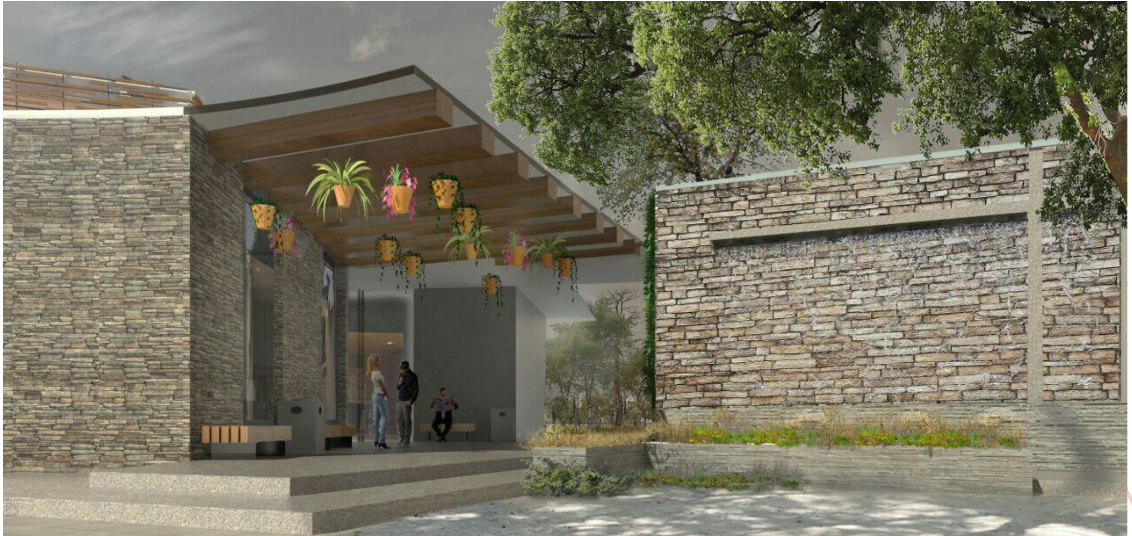
FACHADA PRINCIPAL LADO DERECHO (Acceso a cementerio)
