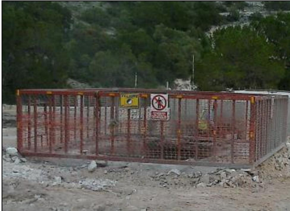
*Ilustración 30. Colocación de la barricada en el contrapozo*
