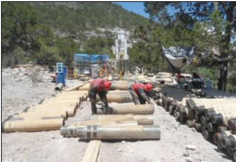
*Ilustración 29. Desinstalación tubería contrapocera pozo Master Drilling*
