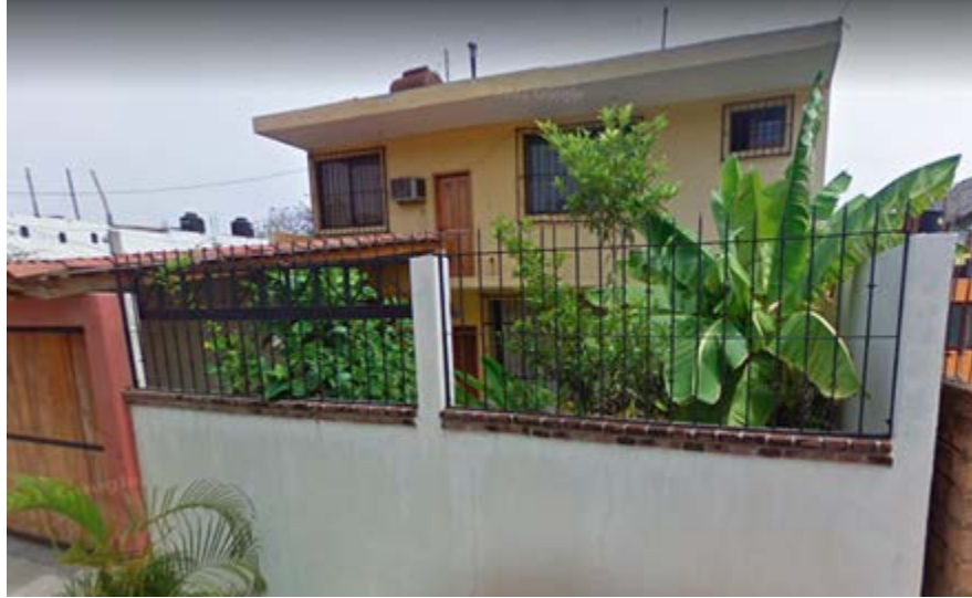
Figura 6-13: Vivienda tipo media. Calle presa Falcon [Streetview, 2022]
