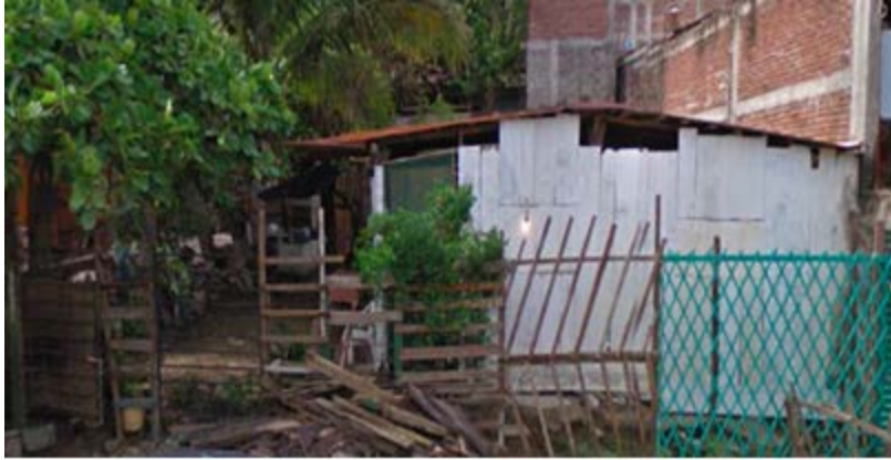
Figura 6-11: Vivienda precaria. Calle paseo de la cantera [Streetview, 2022]
