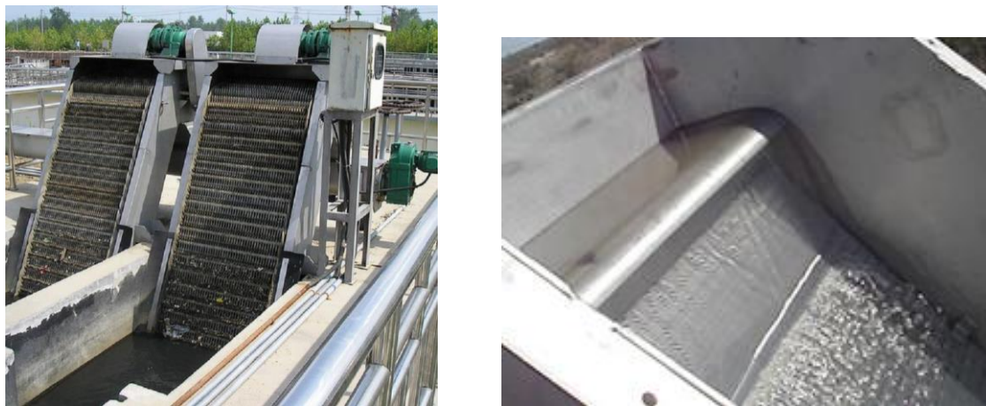
Figura 7. Criba gruesa (izquierda) y criba fina estática (derecha).
