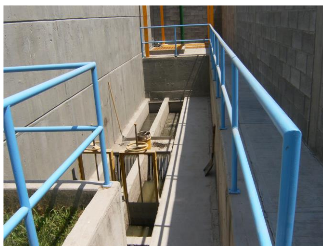
Figura 5. Caja de demasías / Obra de demasías.
