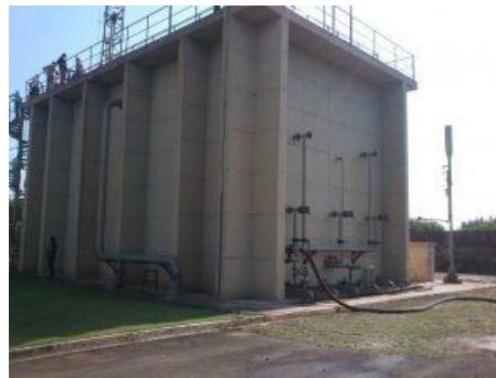
Figura 24. Reactor anaeróbico por lotes secuencial. Fuente: TAERSA, 2020.
