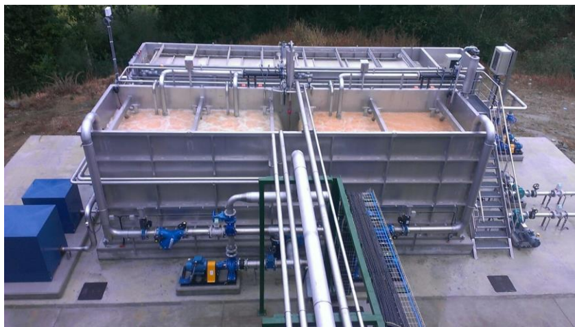
Figura 32. Reactor biológico de membrana para aguas industriales. Fuente: Aguas Industriales, 2014.
