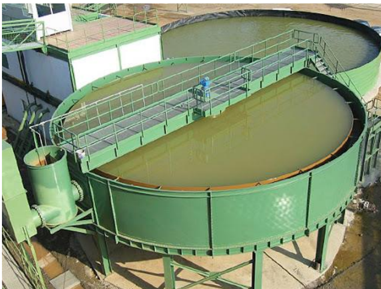
Figura 1. Sedimentador circular.
