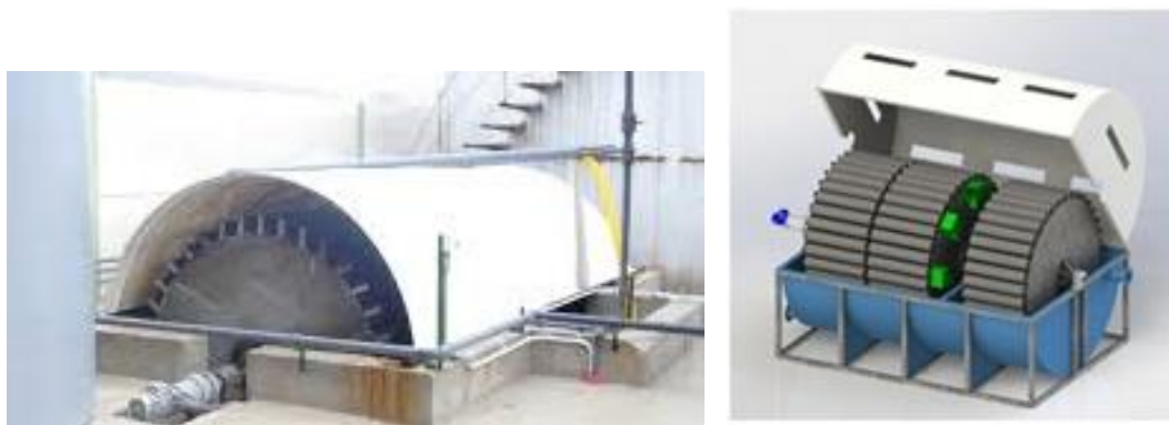
Figura 35. Contactores biológicos rotativos
