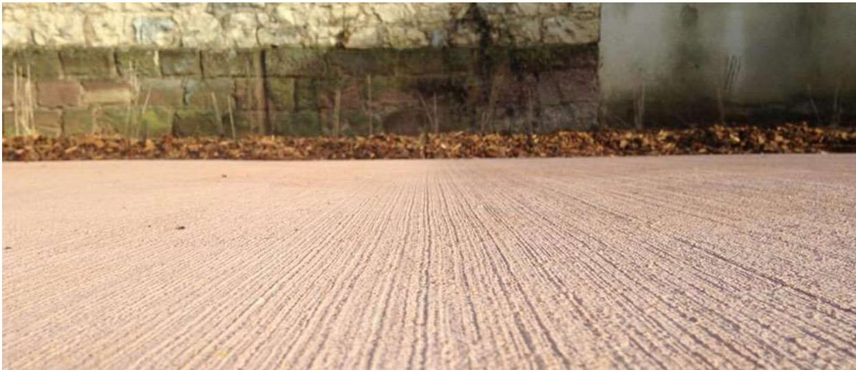
Figura 60. Hormigón rayado. (ARTHORMIGÓN, 2021)
