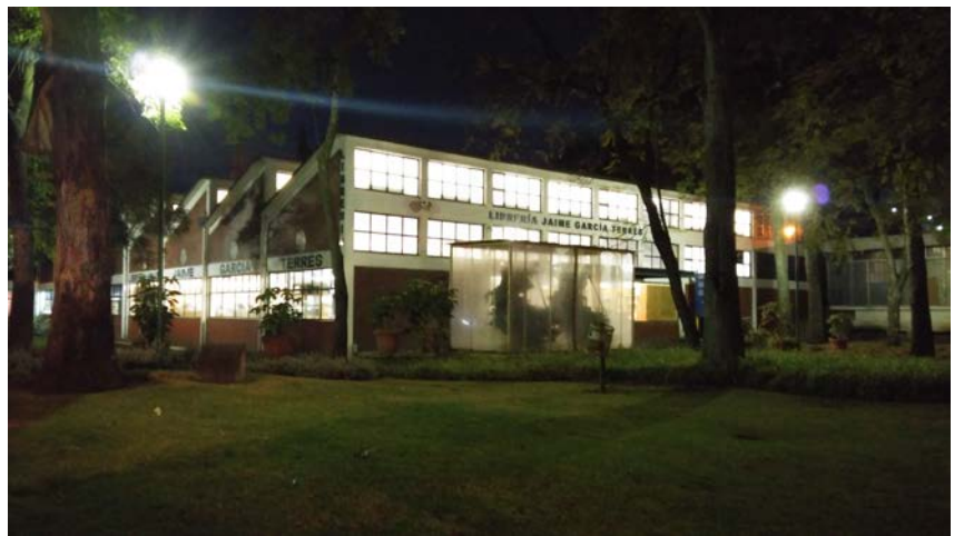
Estado actual del exterior de la librería JGT. Equipo de diseño Librería Jaime García Terrés (LJGT). Abril, 2018.
