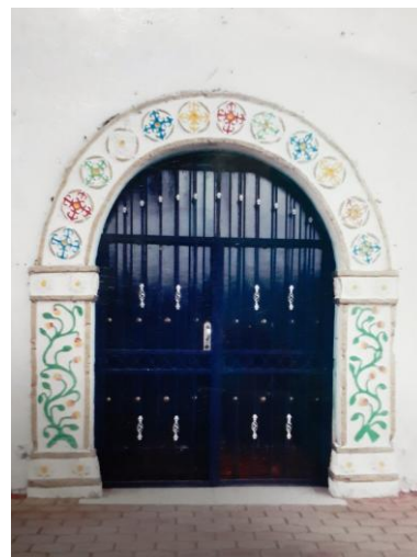
Img. 35. Acceso a la capilla de San Agustín con motivos tequitqui alrededor del arco y jambas (Foto). Elaboración propia (2015)
