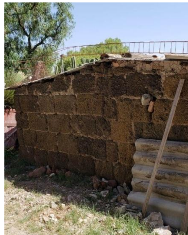
Img. 33. Construcción de mampostería de Chalnene (Fotografía). Elaboración propia (2015)
