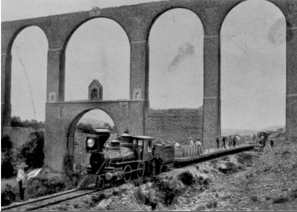
Img 7. Autor anónimo (1900) Ferrocarril pasando por la arquería del Acueducto del Padre Tembleque (fotografía). Fuente: Sinafo, Conaculta-INAH.
