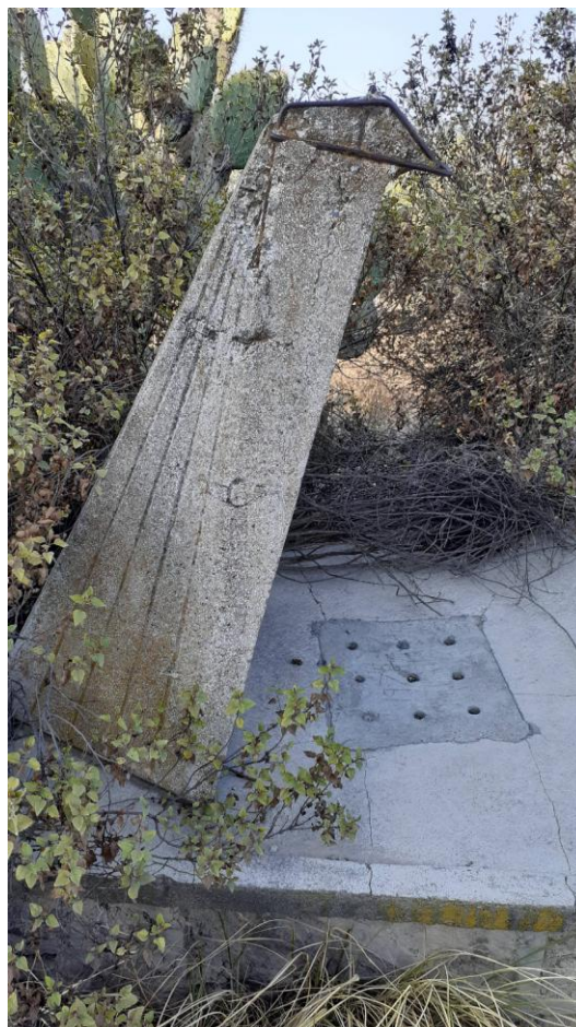
Img. 51. Antigua fuente pública para abastecimiento de agua potable (Fotografía). Elaboración propia (2021)
