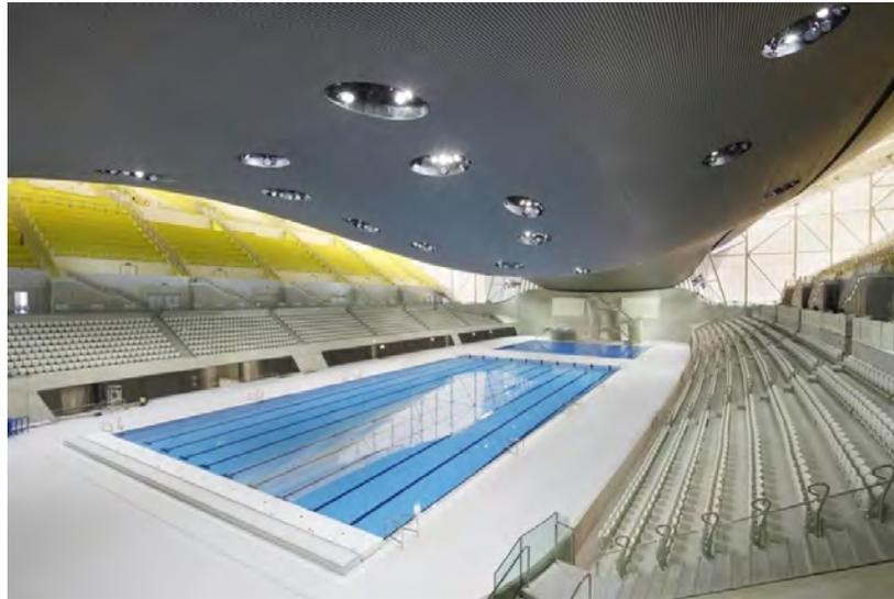
El diseño de la cubierta responde a la isóptica de los espectadores en las gradas provisionales.
