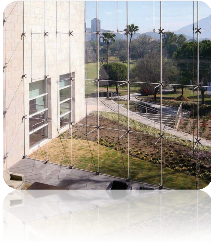
Figura 2.16. Sistema de soporte de araña a tensores
