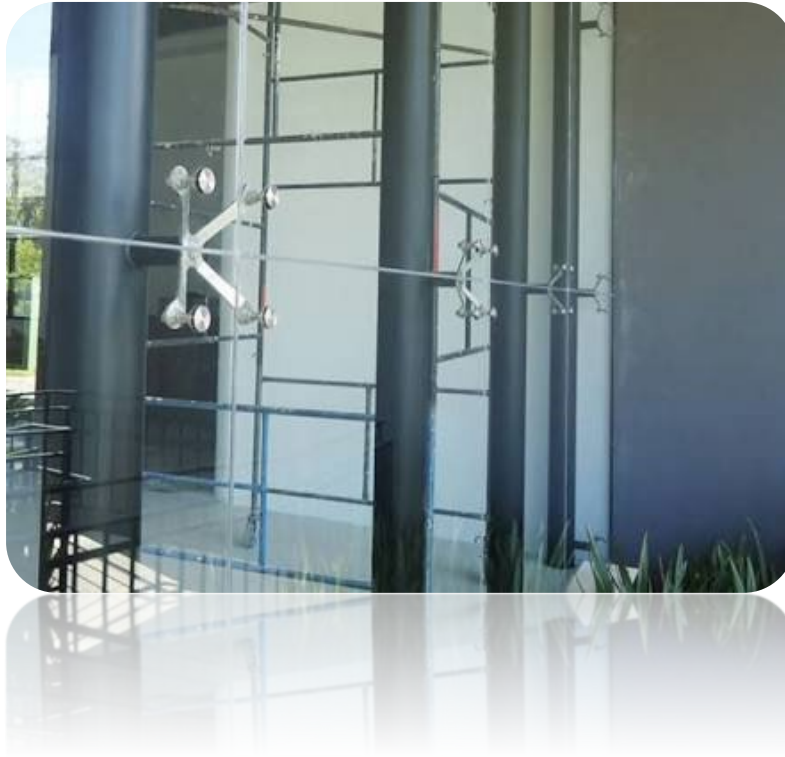
Figura 2.15. Sistema de soporte de araña a estructura
