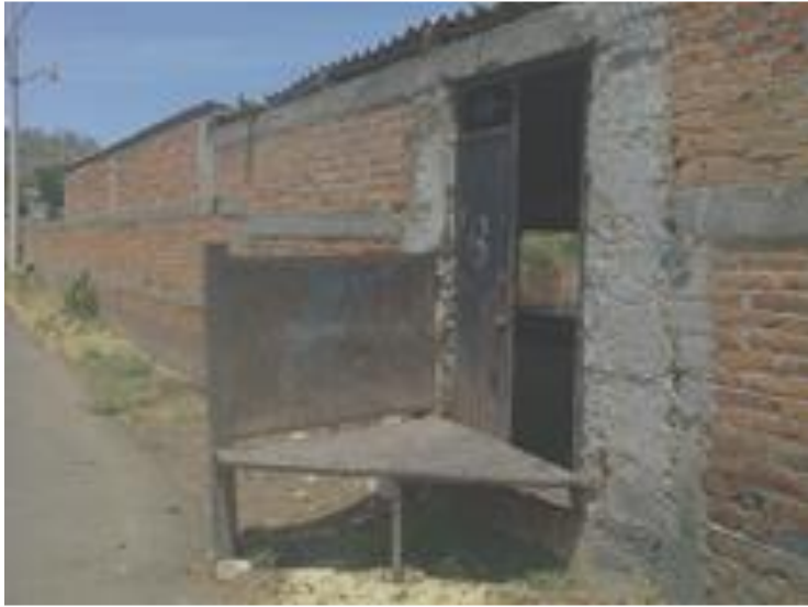
Plataforma de descarga cerdos.
