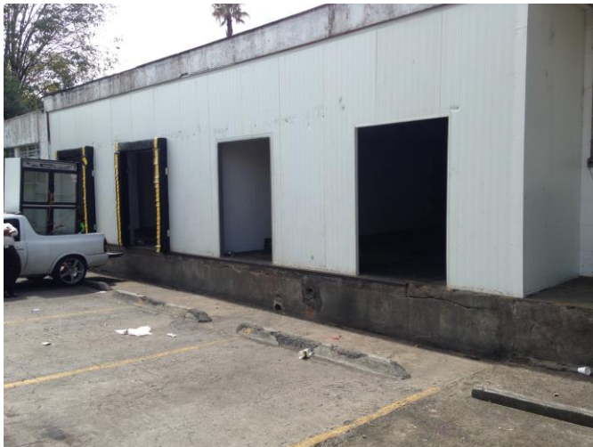
En esta área se suben las carnes a los camiones y camionetas que distribuyen la carne por la ciudad. Así mismo cuenta con un desnivel que va de acuerdo a la altura del transporte.
