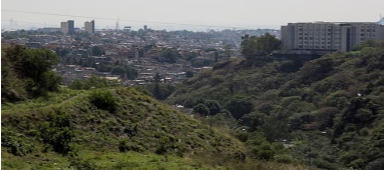
Figura 2. Ejemplo de una Barranca al poniente de la Ciudad de México, donde se pueden apreciar laderas escarpada Imagen tomada de periódico Milenio, 2018.
