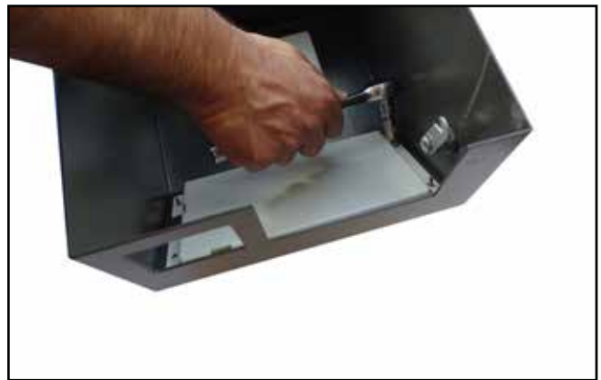
Fig. 4. Fijala con tuercas de \frac{1}{4} " con la ayuda de la matraca con dado hexagonal de \frac{1}{4} ". Fuente propia.
