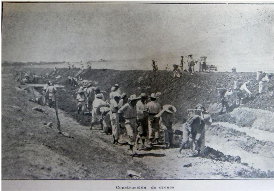
Construcción de drenes
