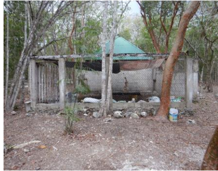
Fotografía 2: Vista exterior del corral 1
