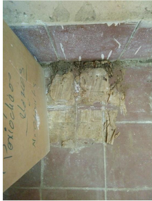
Imagen 12. A la izquierda: Cajas prensadas y apiladas con claras marcas de humedad. A la derecha: Cartón pegado al piso de una caja en la base de la pila.
