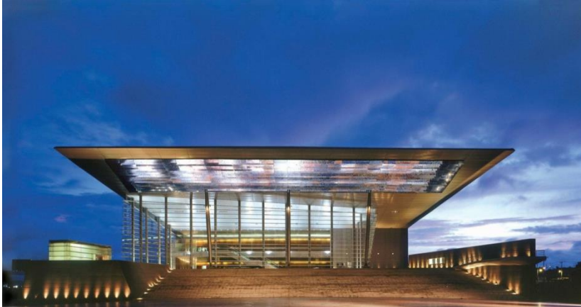
1.- Fachada de acceso
