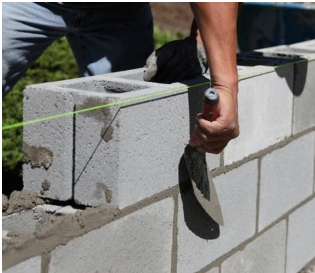
Muro a base de block hueco (Fotografía) Recuperado de: https://lugon.com.mx
