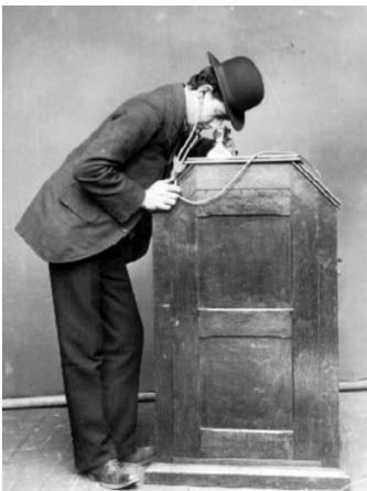
Fotografía del kinetófono, patentado en 1895. Este dispositivo inventado por Edison y Dickson, pretendía unificar el kinetoscopio y el Fonógrafo, pero el artefacto presentaba varias deficiencias y fue opacado después por otros artefactos. Foto: victorian-cinema-net
