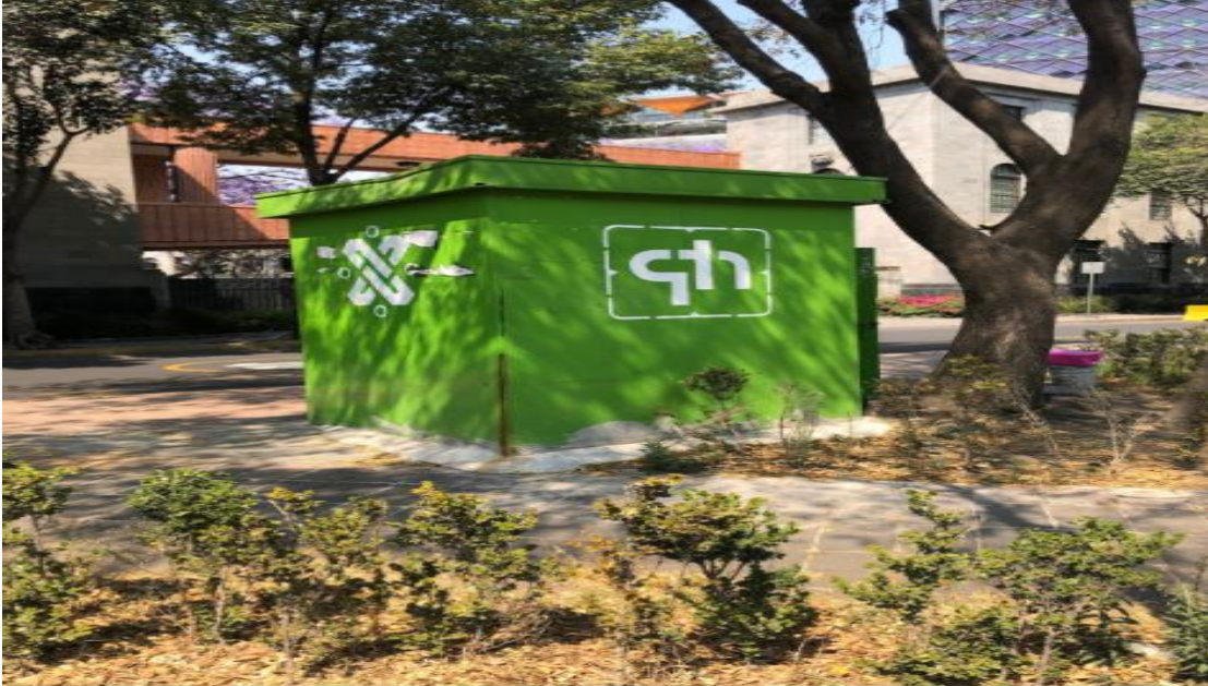
Imagen 27. Caseta de monitoreo de unidades de la RTP en CETRAM Chapultepec
