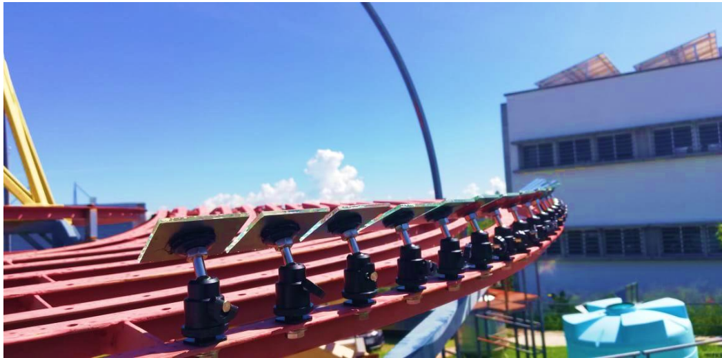
Figura 4.17. Minirotulas con espejos instalados en el último anillo del FRESNEL. El arreglo se encuentra en posición de focalización.
